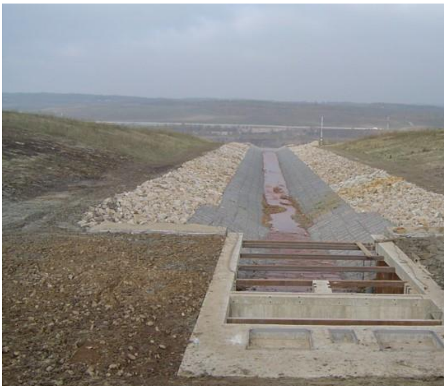
Obrázek 6: Jímací objekt-otevřené koryto (Ráž, 2009)
