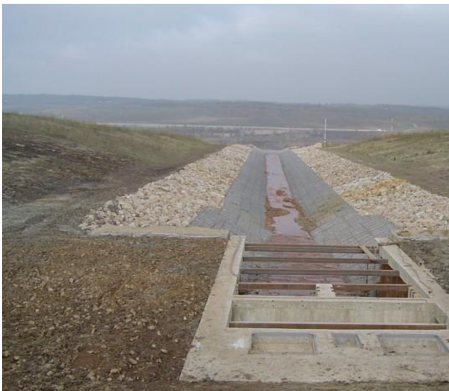
Obrázek 6: Jímací objekt-otevřené koryto (Ráž, 2009)
