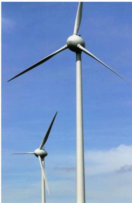
Obrázek 9: 2x 600 kW Enercon E-40 [29]
