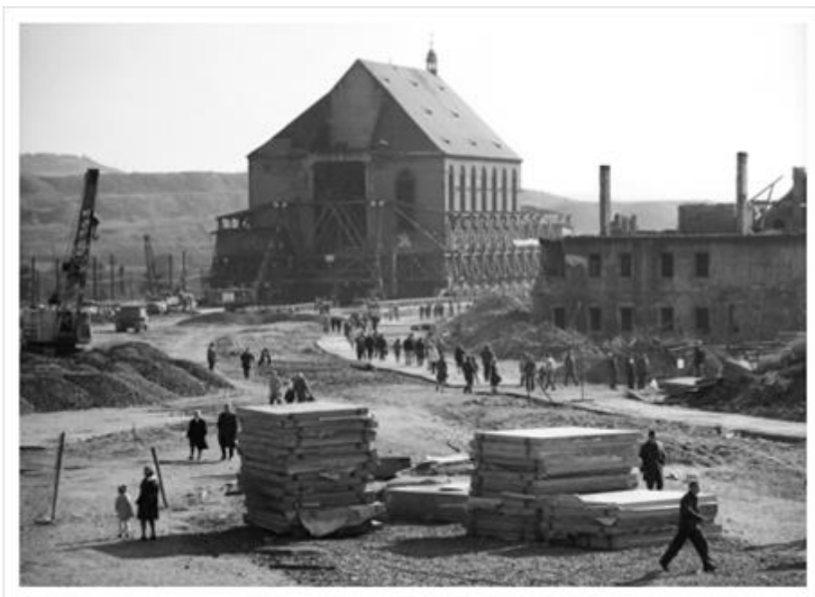
Kostel na kolečkách aneb stěhování kostela Nanebevzetí Panny Marie dostupné z http://listy.mesto-most.cz/predni-cesti-historici-budou-v-knihovne-prednaset-a-diskutovat-o-bourani-stareho-mostu/d-7159
