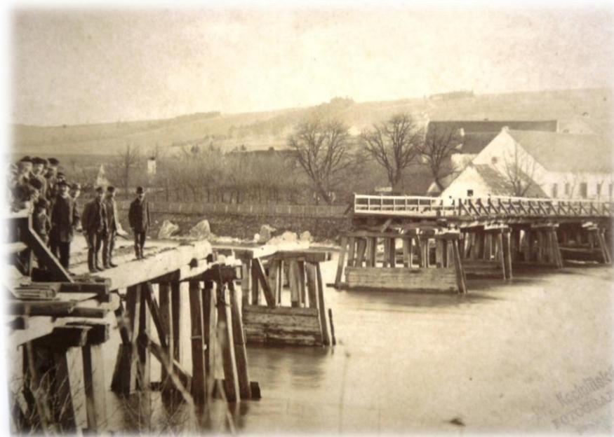
Obrázek č. 9 – Vltavotýnský dřevěný most zničený dřenicí
