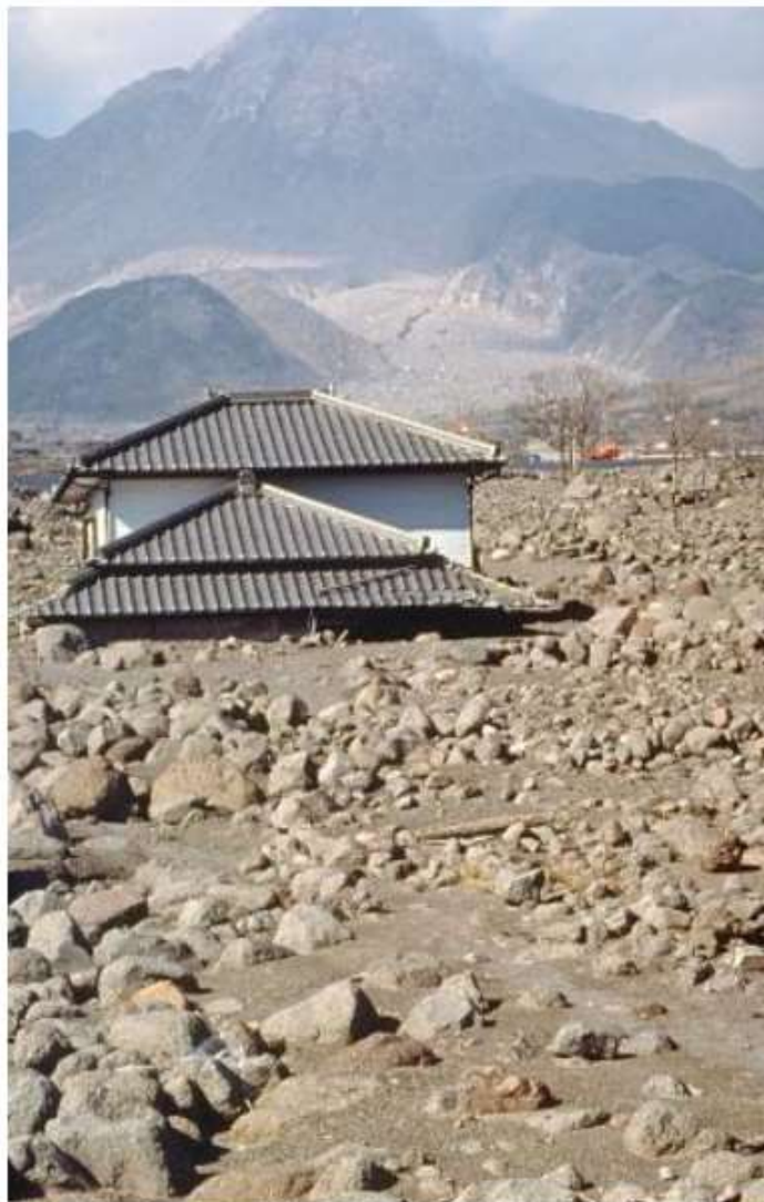
Obr. 3: Dům pohřbený pod laharem následkem výbuchu sopky Unzen Zdroj: Tom Pierson, 1995 (US Geological Survey).
