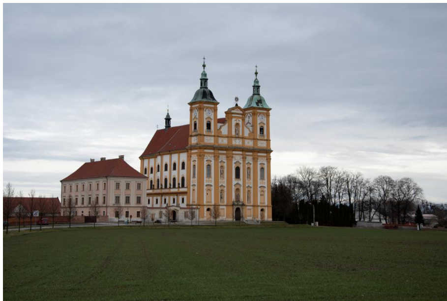
Obrázek č. 26 Obrázek č. 2 ve formátu RAW – Poutní kostel Panny Marie , zdroj: vlastní
