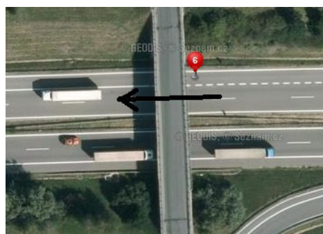
Obr. č. 8 - podjezd mostu
