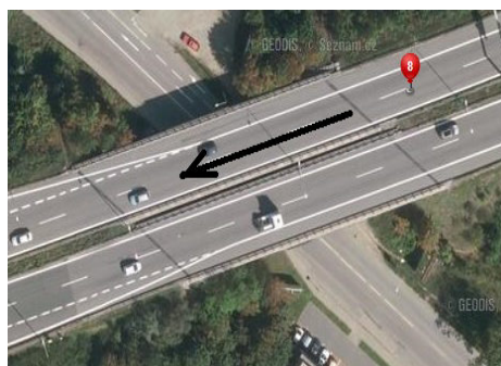
Obr. č. 10 - přejezd mostu
