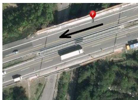
Obr. č. 9 - přejezd mostu
