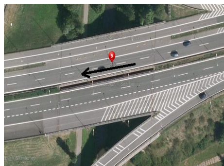
Obr. č. 11 - přejezd mostu
