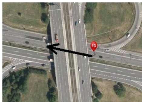
Obr. č. 15 - podjezd mostu
