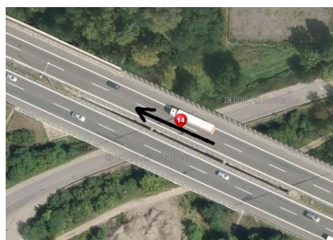
Obr. č. 16 - přejezd mostu
