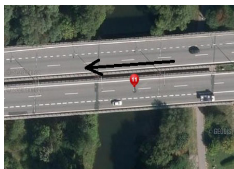
Obr. č. 13 - přejezd mostu
