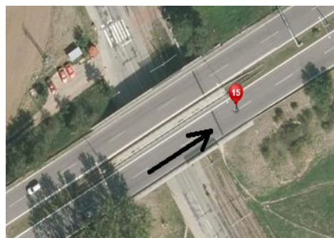
Obr. č. 17 - přejezd mostu
