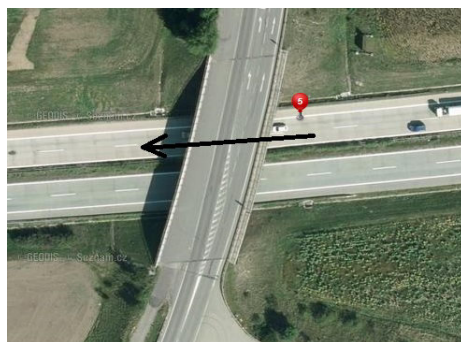
Obr. č. 7 - podjezd mostu
