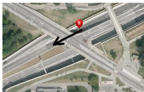
Obr. č. 26 - podjezd mostu
