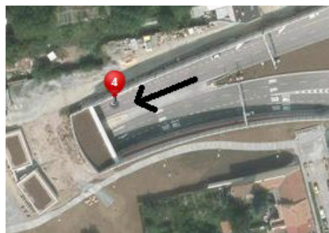
Obr. č. 25 - vjezd do tunelu
