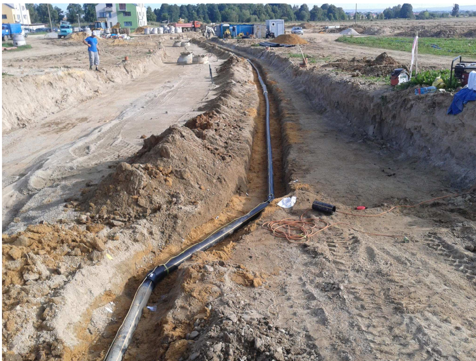
Příloha 10: Průběh stavebních prací (pokládka plynovodu).
