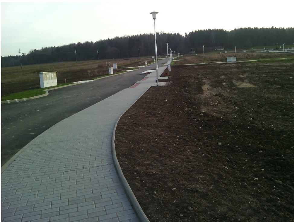
Příloha 11: Dokončení stavebních úprav
