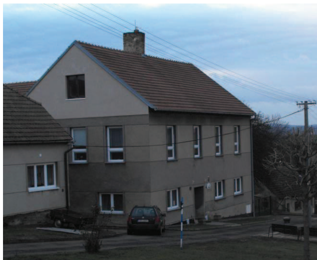
Obr. č. 22 – Budova mateřské školy
