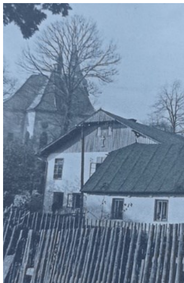
Obr. 12 Synagoga ve Světlé nad Sázavou 152
