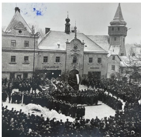
Obr. 10 Společný pohřeb obětí leteckého útoku 122
