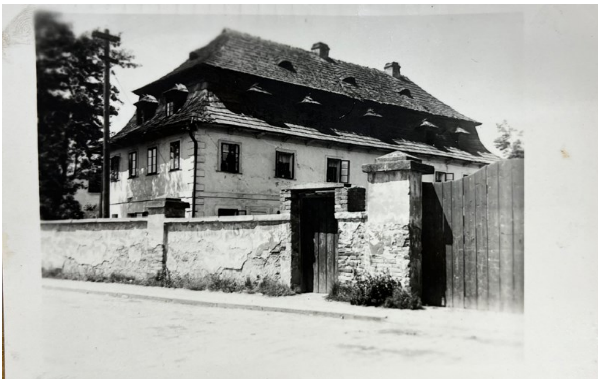
Obr. 11 Brusárna Karlov v Nádražní ulici z roku 1941 240
