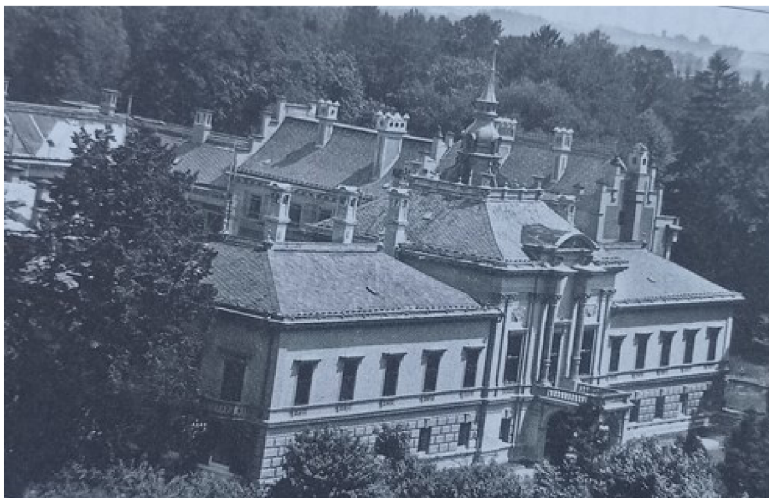
Obr. 7 Pohled na zámek z roku 1938, kdy v něm sídlili uprchlíci 236
