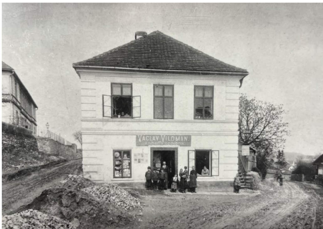
Obr. 17 Dům mezi ulicemi Komenského (nalevo část budovy měšťanské školy) a Nádražní, předtím, než byly ulice vydlážděné, nejspíš 20. léta 246
