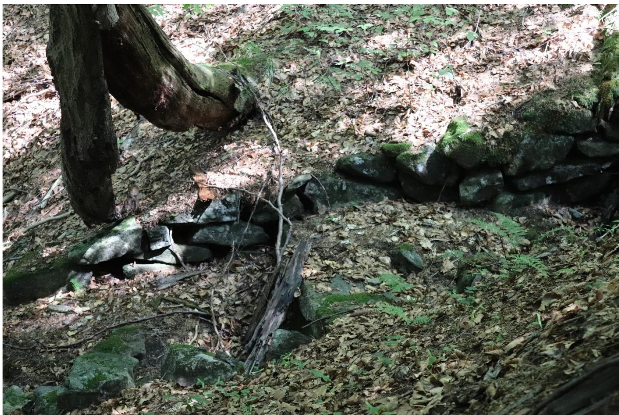
Příloha 10 Stabilizační kamenná zídka v pozadí s tzv. opilým stromem Zdroj: Němec 2022
