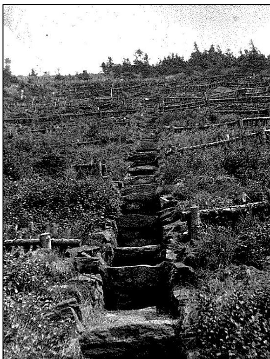
Příloha 6 Kaskádovité kamenné žlaby sloužící pro odvodňování svahů při vydatných deštích Zdroj: Sokol 1965
