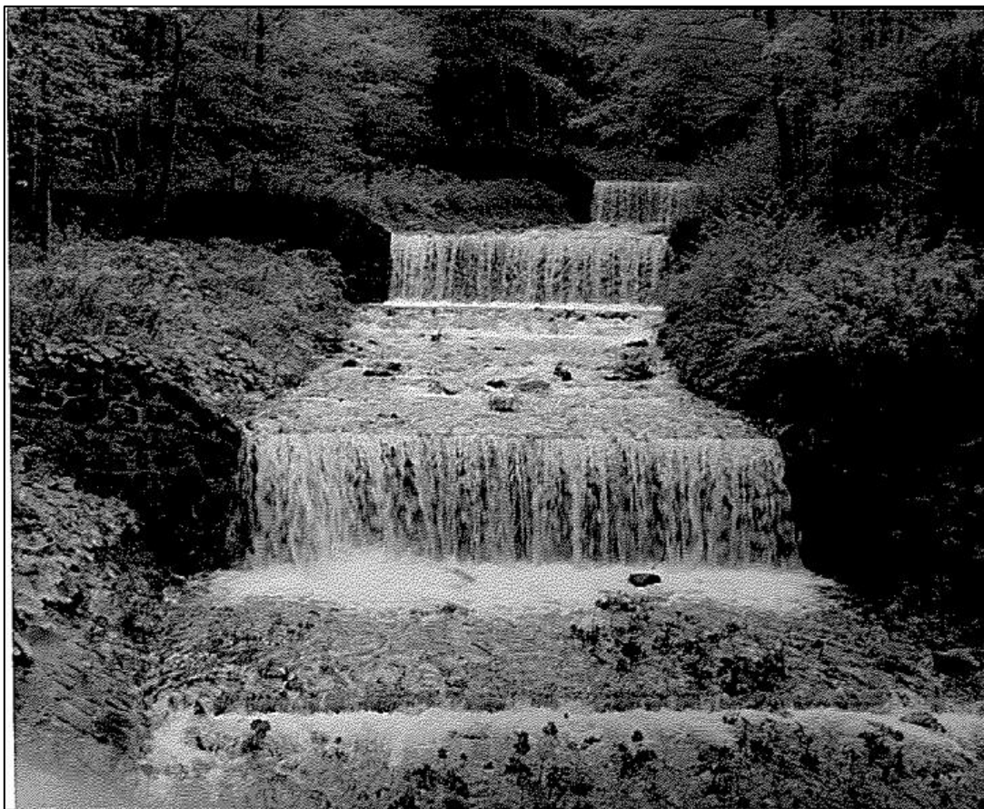
Příloha 4 Zjišťování koryt řek kamennými kaskádami k zachycení splaveniny ze svahů Zdroj: Sokol 1965
