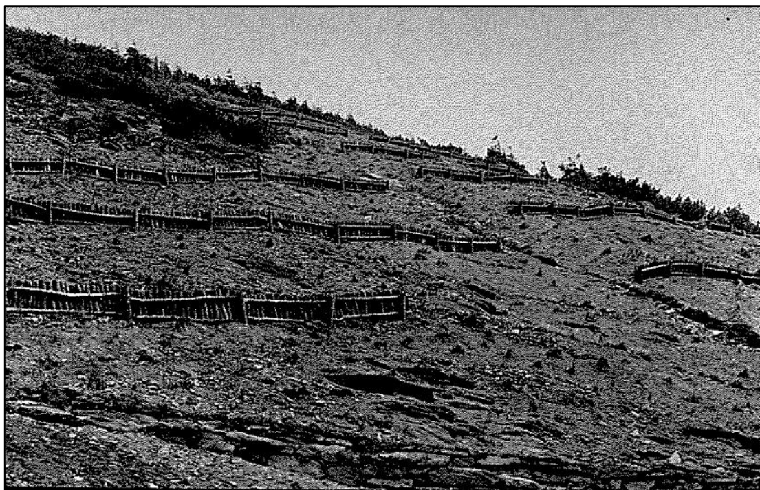
Příloha 5 Technické zajišťování svahů pomocí palisádových plotů Zdroj: Sokol 1965
