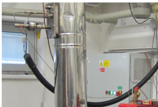
Obr. 14 Umístění sondy a hadice u kotle Dakon
