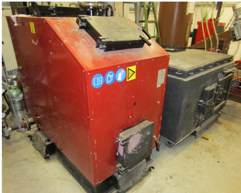
Obr. 12 Kotel Gemos KWH 110 se zplyňovací komorou ZKG
