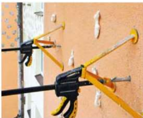
Obr. č. 4: Dokotvení nestabilního zateplovacího systému injektovanými hmoždinkami, (Stomix, 2014)
