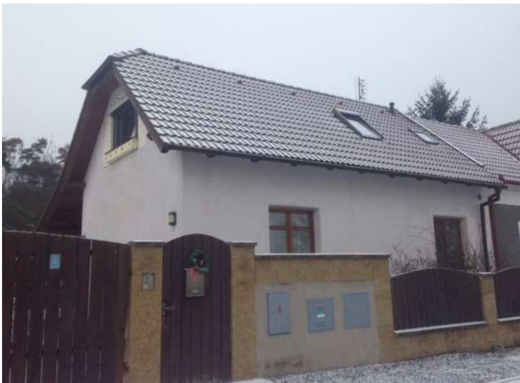
Příloha č. 6 – Pohled z ulice po částečné rekonstrukci, (Šohaj, 2000)
