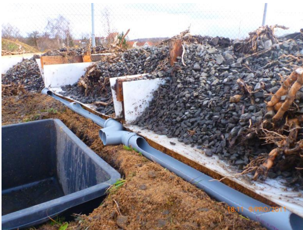
Obr. 14-23 Pohled na mělké prostory připravených ploch, určených k vymrznání směsi filtračního materiálu
