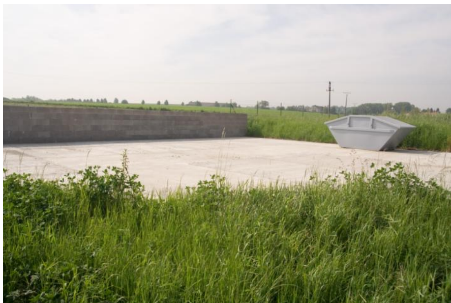
Obr. 3-2 Zpevněná plocha pro vymrznutí rozprostřeného zakolmatovaného filtračního materiálu
