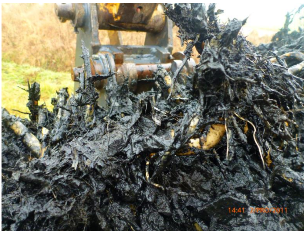
Obr. 14-19 Zakolmatovaný materiál – směs štěrku, kořenů rostlin a kolmatantu (vyplaveného kalu z usazovací nádrže)
