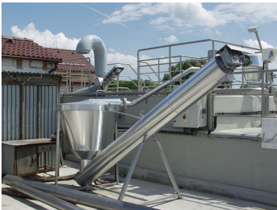
Obr. 3-3 Pohled na strojní pračku písku ( http://wtc-macro.com )
