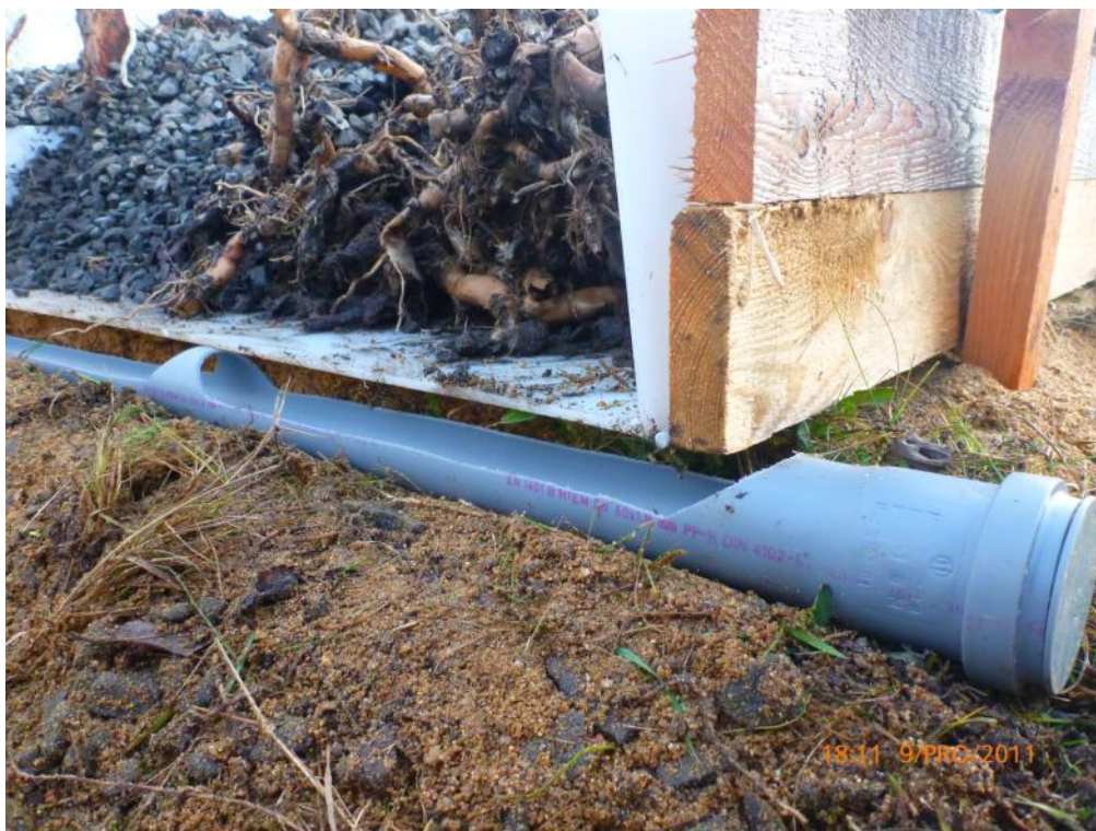
Obr. 14-24 Pohled na odvodňovací sběrný žlab, umístěný pod nejnižší hranou připravené plochy
