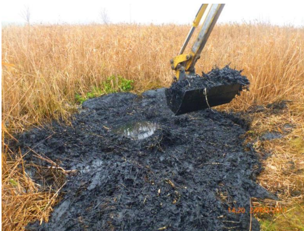
Obr. 14-17 Těžba zakolmatovaného materiálu po odstranění rostlin a usazené vrstvy kalu na povrchu
