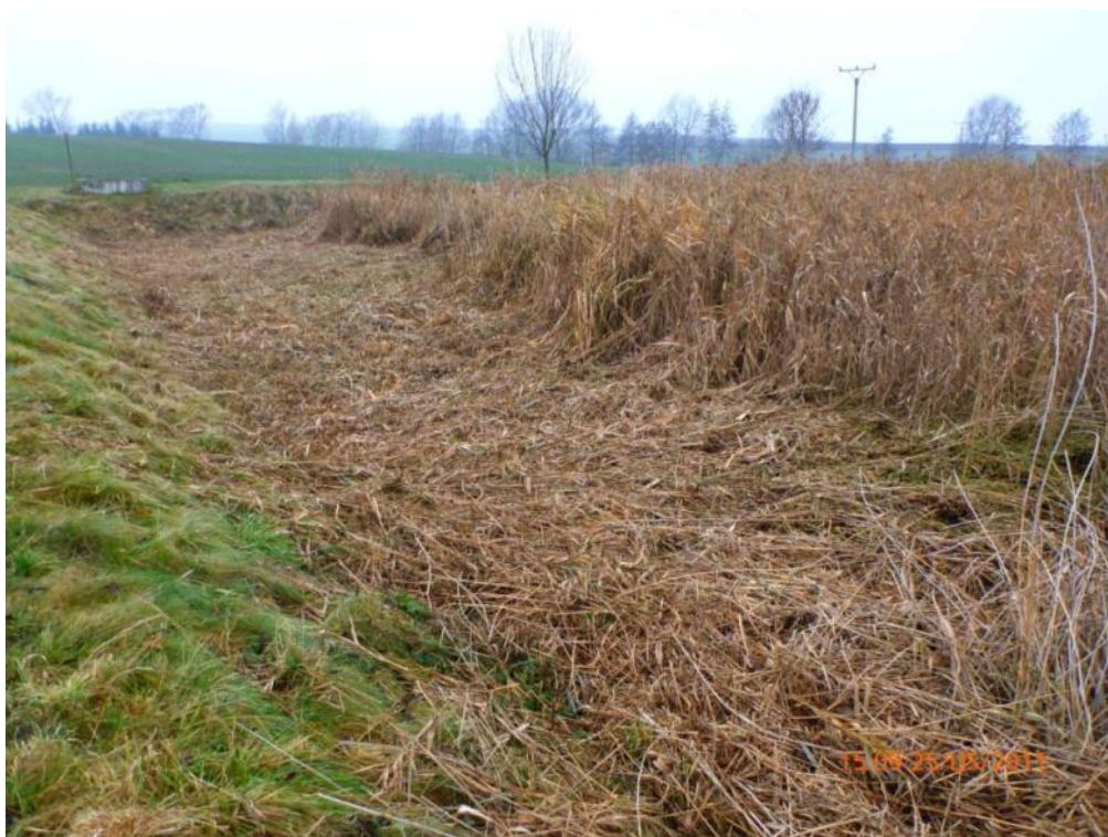
Obr. 14-16 Příprava zakolmatovaného filtračního odtěžením mokřadních rostlin
