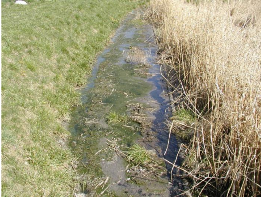
Obr. 3-1 Špatně navržené mechanické předčištění ovlivní prostupnost filtračního materiálu
