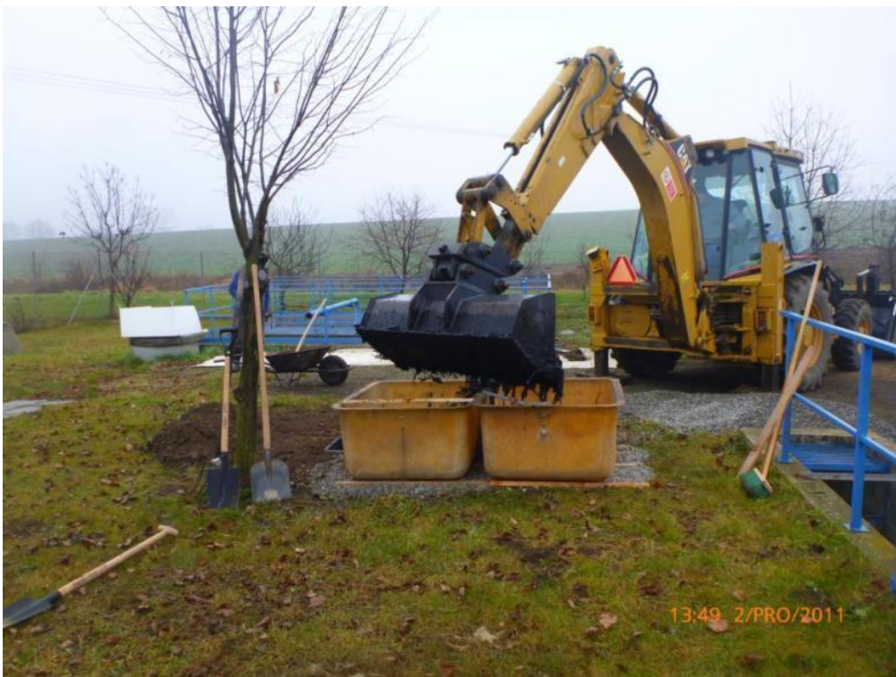
Obr. 14-12 Aplikace anaerobního kalu, těženého z povrchu filtračního pole
