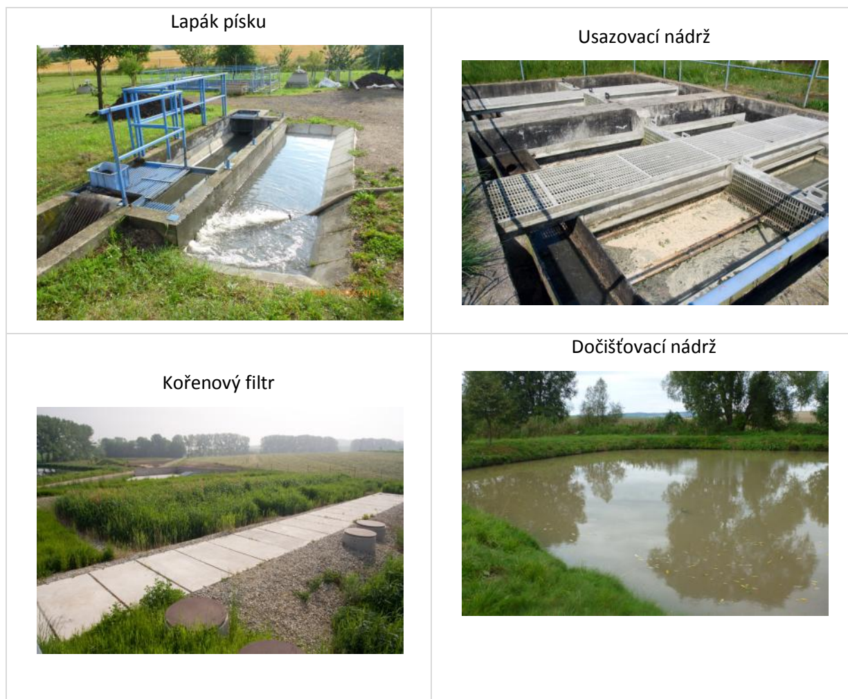
Obr. 2-2 Zobrazení základních technologických zařízení na KČOV
