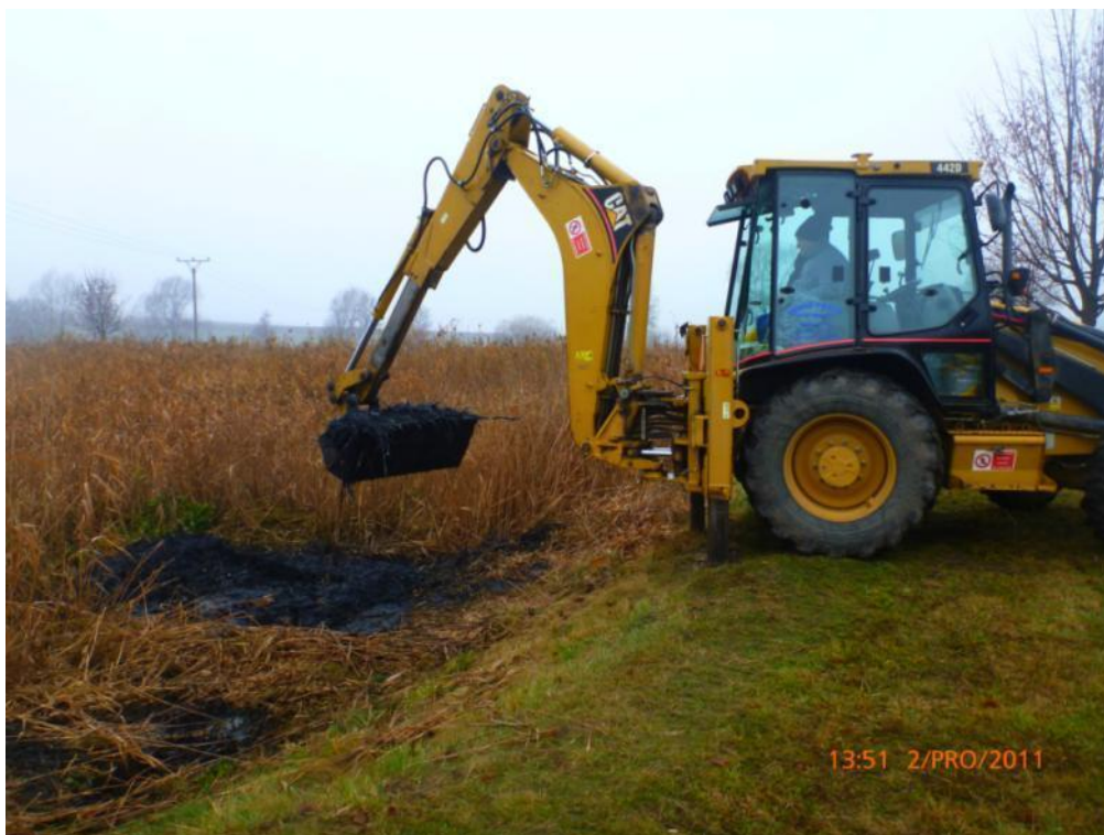
Obr. 14-18 Těžba filtračního materiálu bez nutnosti vjezdu těžké techniky na filtrační pole
