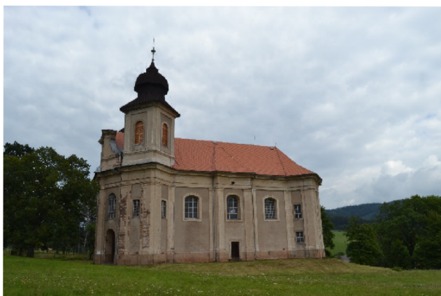
Obrázek č. 17. - Kostel sv. Markéty v Šonově
