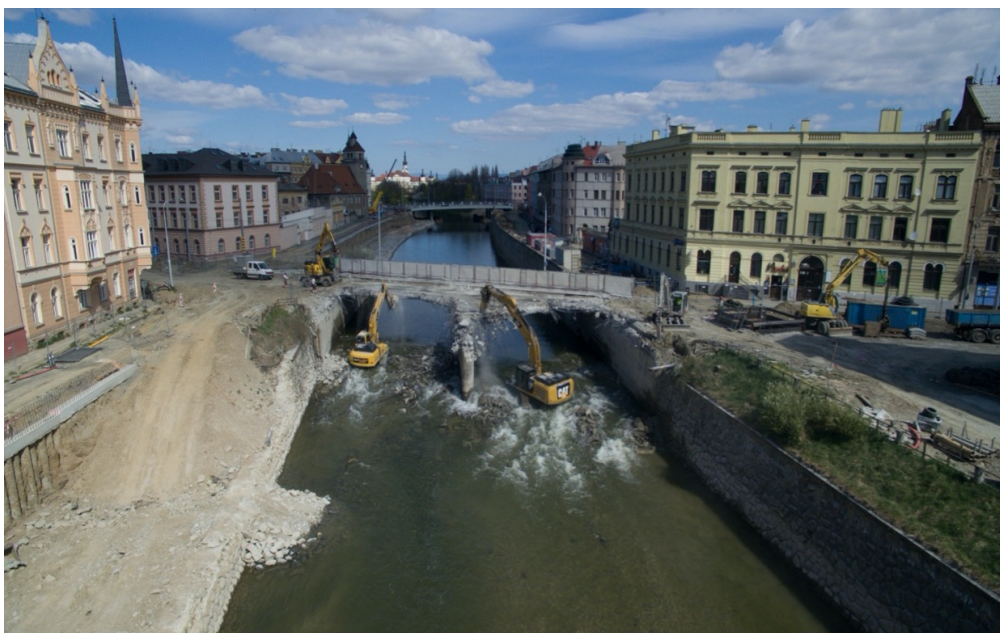
Příloha 18 - Pohled z výšky na demolici mostu, duben 2020 (protipovodnovaopatreni.olomouc.eu)
