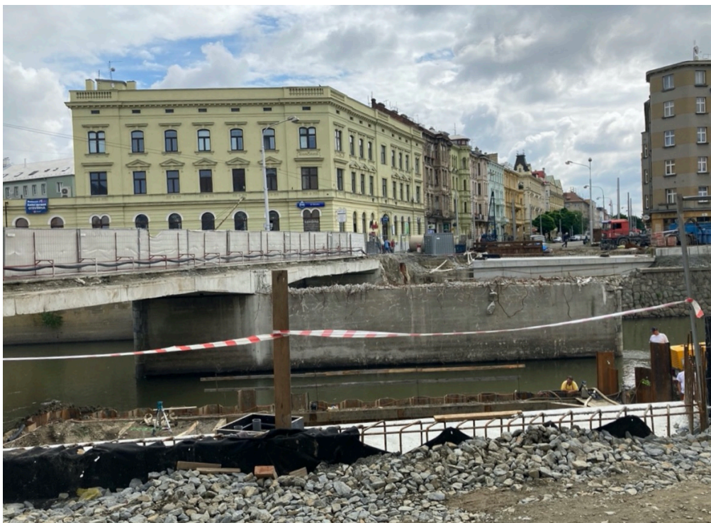
Příloha 12 - Pohled na průběh bourání první poloviny mostu na Masarykově třídě, červenec 2020 (foto autor)
