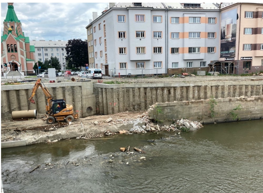
Příloha 10 - Bourání nábreží při mostě na Komenského ulici, červenec 2020 (foto autor)
