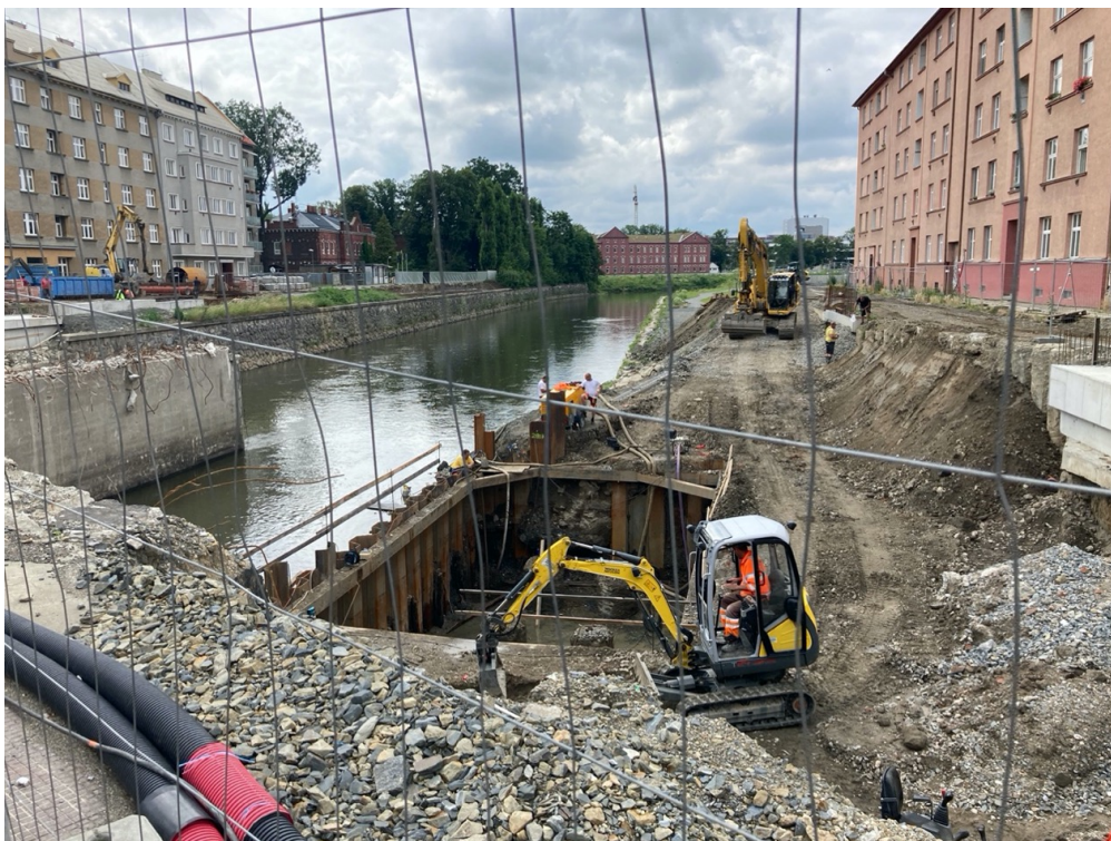
Příloha 13 - Průběh stavebních úprav, červenec 2020 (foto autor)
