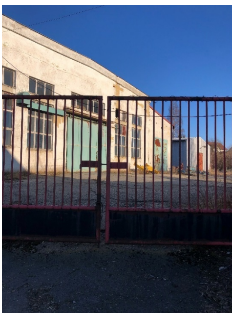
Fotografie 4.21: Opuštěná budova (zdroj: vlastní)
