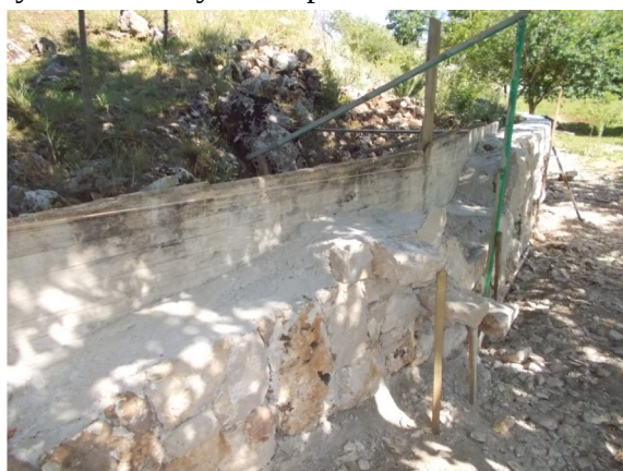
Obr. 2: Zídka betonovaná Zdroj: autor
