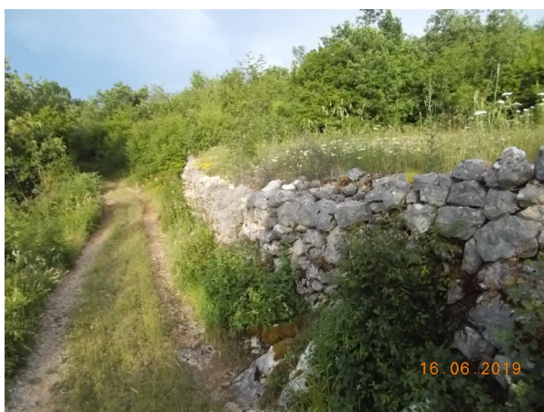
Obr. 14: Opěrná zídka terasy bloku 1 Zdroj: autor
