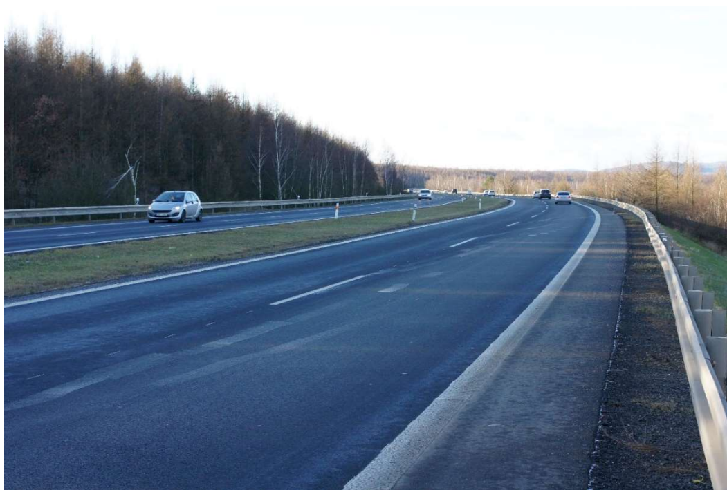
Obr. č. 26: Silnice I/13 u dolu Komořany (autor: Jiří Popper, 2017)
