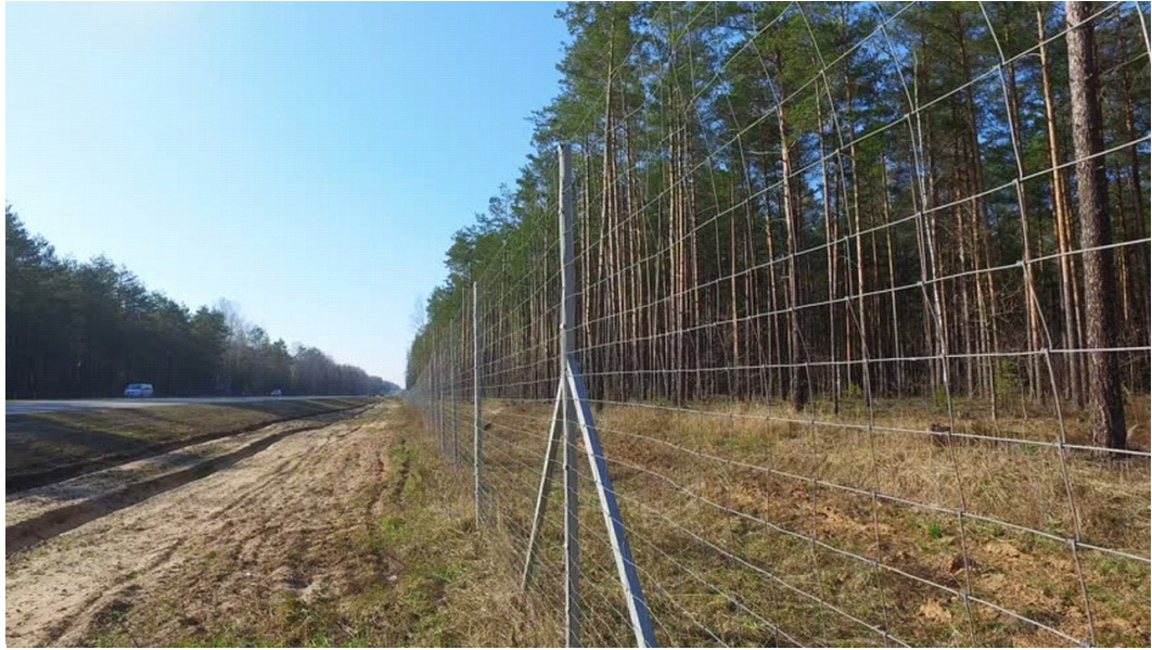
Obr. č. 6: Oplocení dálnice (Jan Hándl, 2018)
