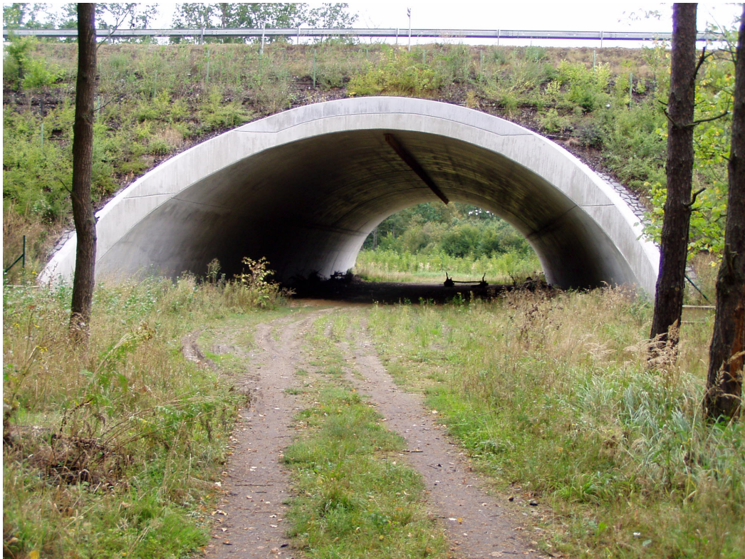
Obr. č. 13: Zvířecí podchod-propustka ( www.forumochranyprirody.cz , 2017)
