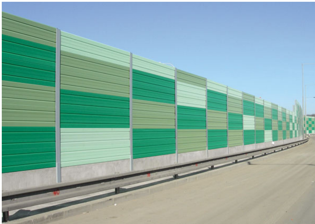
Obr. č. 19: Protihluková stěna (www.casopisstavebnictvi.cz, 2010)
