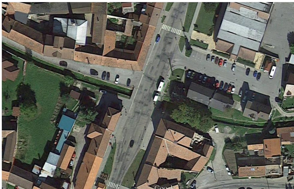
Obrázek 45: Most 376 – 006 na ulici Komenského přes Lysický potok [9]
