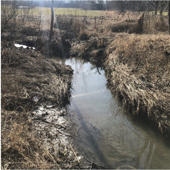
Foto 64: pohled proti proudu ve spodní části úseku
