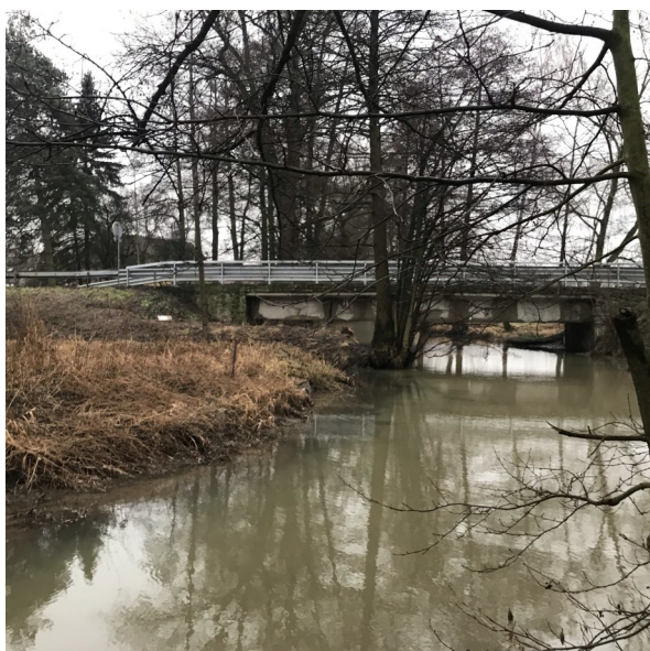
Foto 23: pohled na most v horní části úseku
