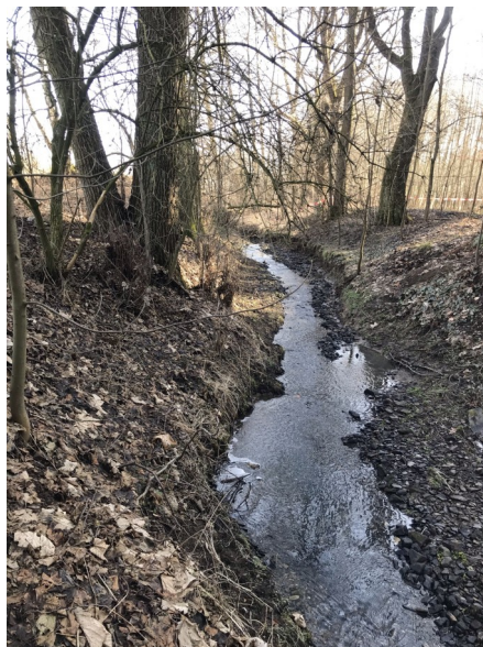
Foto 74: pohled proti proudu ve střední části úseku
