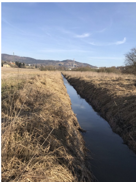
Foto 83: pohled proti proudu v horní části úseku
