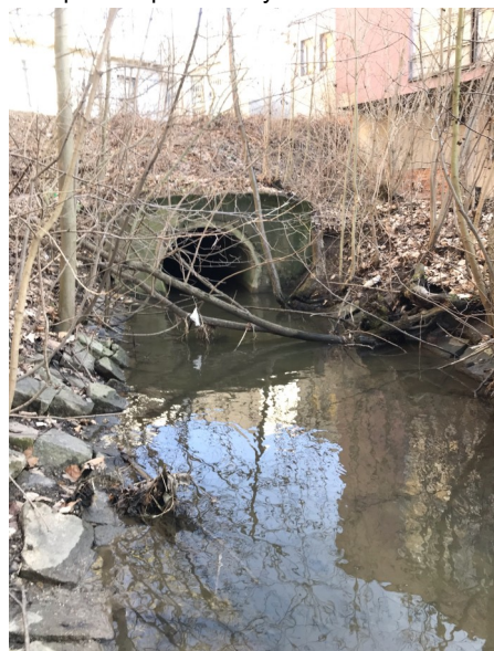
Foto 90: pohled na vyústění zatrubněné části toku
