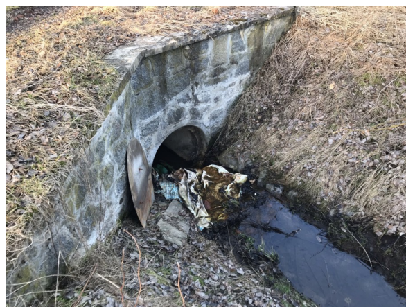
Foto 124: pohled na zaústění zatrubnění (zásobování koupaliště)
