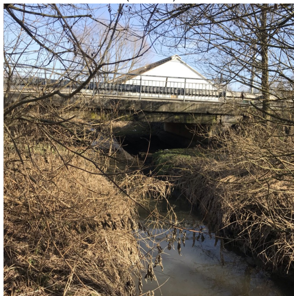
Foto 84: pohled na most (přechod do dalšího úseku)
