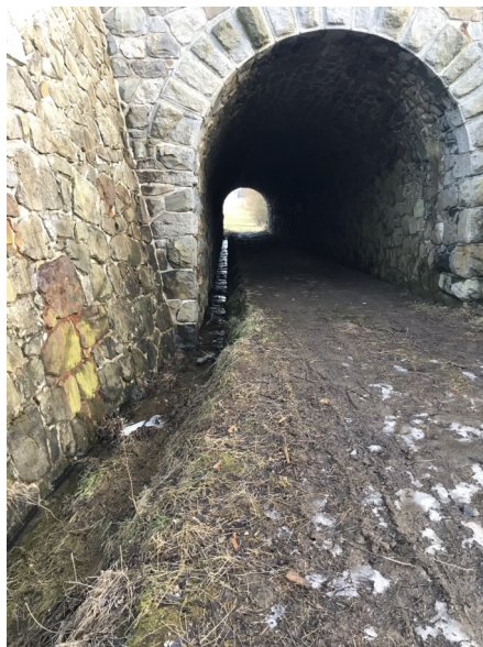
Foto 132: pohled na koryto v tunelu pod železní
