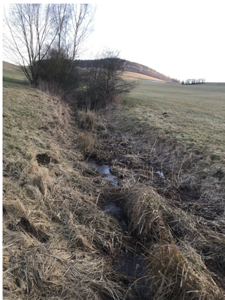
Foto 135: pohled proti proudu v horní části úseku
