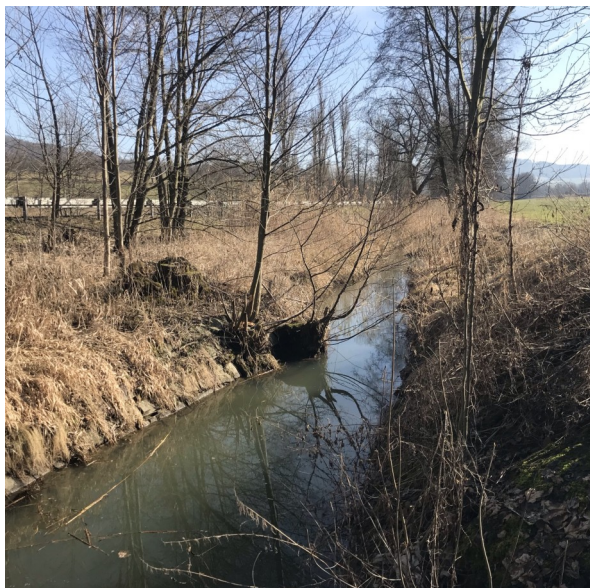
Foto 52: pohled na levý břeh - část. opevnění břehů (komunikace)
