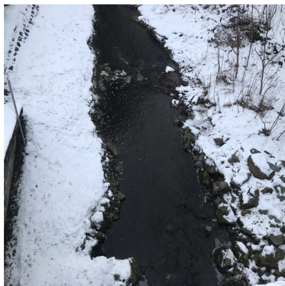
Foto 44: pohled na koryto těsně pod hrází Nov. rybníka
