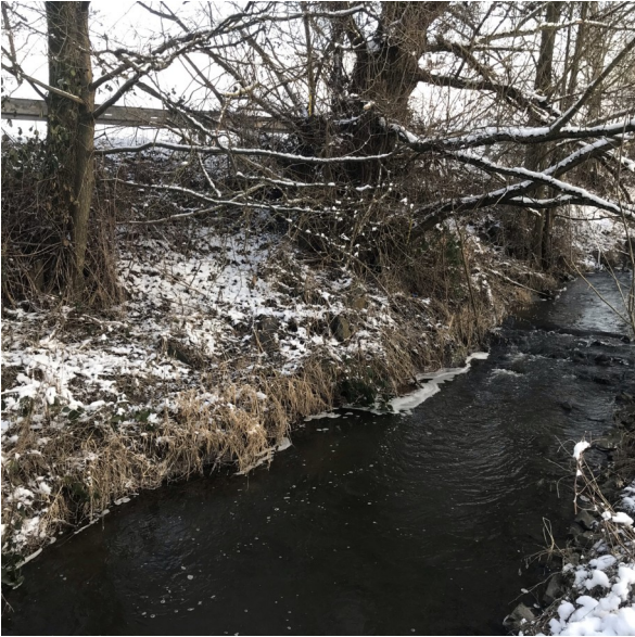
Foto 13: pohled na pravý břeh (komunikace)
