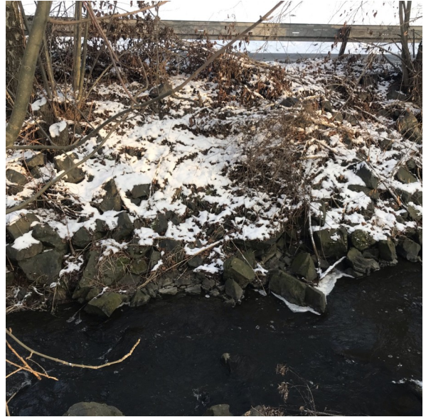
Foto 14: pohled na opevnění pravého břehu (násyp komunikace)
