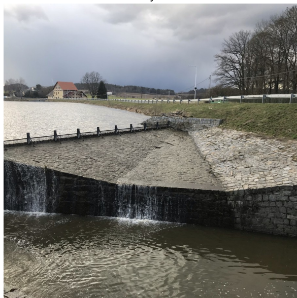
Foto 48: pohled na bezpeč. přeliv
