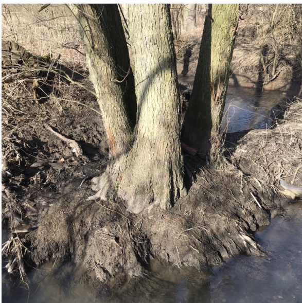
Foto 68: pohled na stabilizaci koryta dřevinnou vegetací
