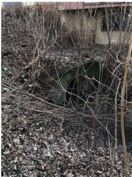
Foto 91: pohled na vyústění zatrubněné části toku
