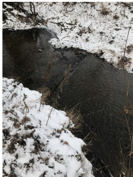
Foto 40: pohled na příčný práh
