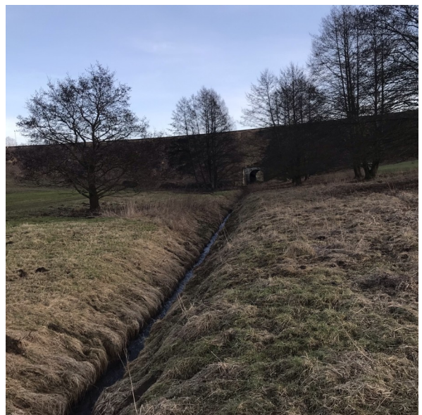
Foto 130: pohled proti proudu ve střední části úseku
