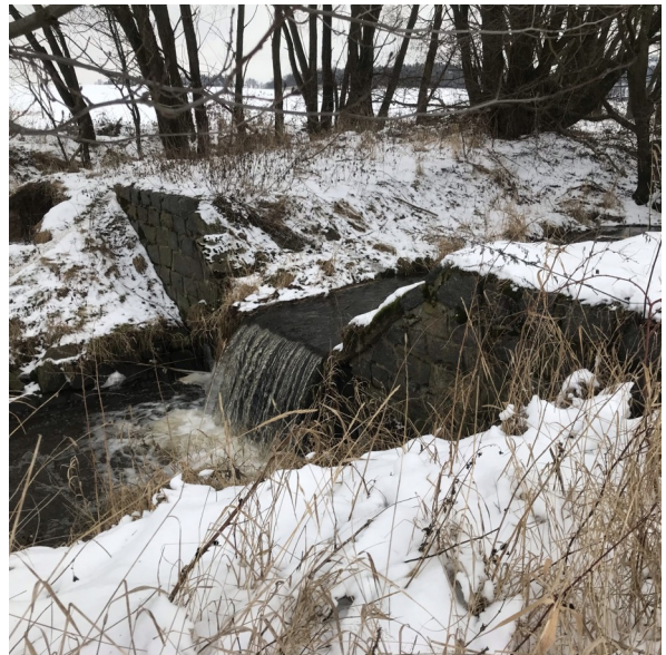
Foto 38: pohled na spádový objekt za stavidlem
