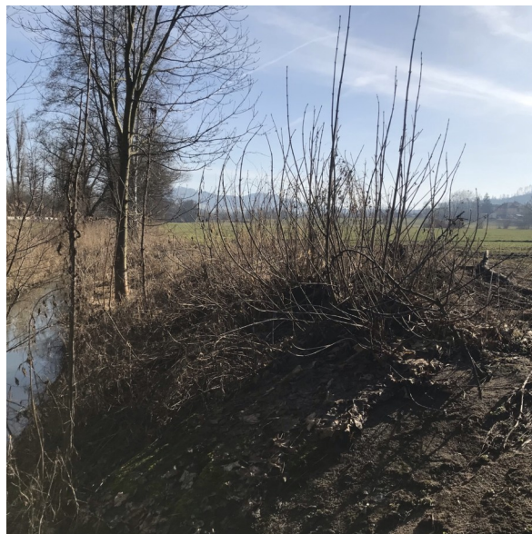
Foto 53: pohled na levý břeh
