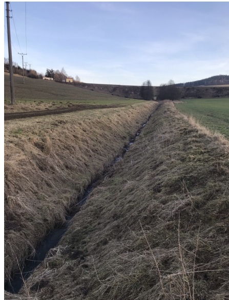
Foto 128: pohled proti proudu ve střední části úseku
