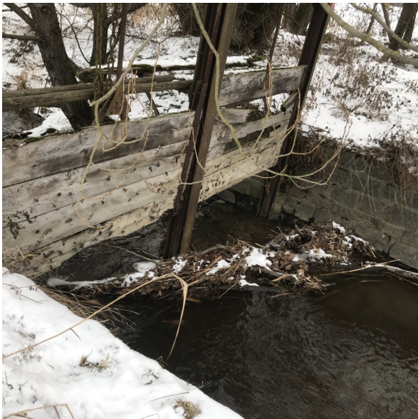
Foto 37: pohled na stavidlo
