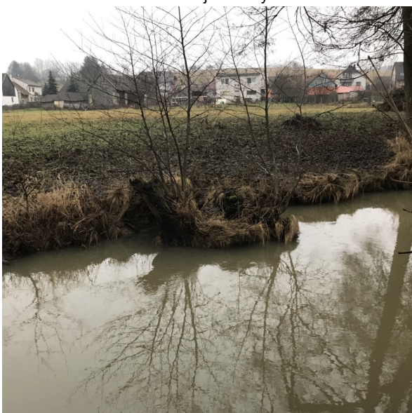
Foto 29: pohled na zbytky dřeviny vyskytující se v březích (pravý břeh)
