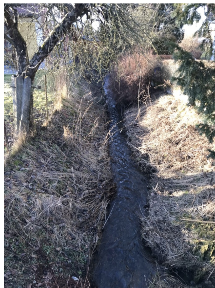
Foto 101: pohled na koryto po proudu v horní části úseku
