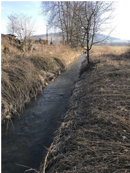
Foto 79: pohled proti proudu ve spodní části úseku
