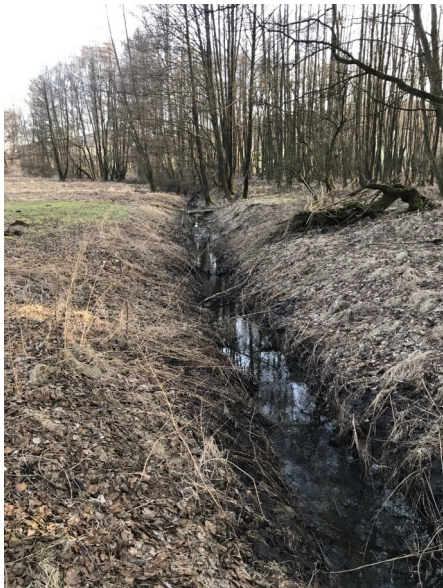
Foto 119: pohled proti proudu ve spodní části úseku
