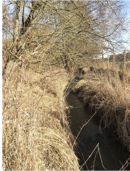
Foto 86: pohled proti proudu ve střední části úseku
