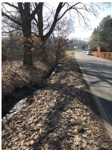
Foto 78: pohled na pravý břeh (komunikace) v horní části úseku
