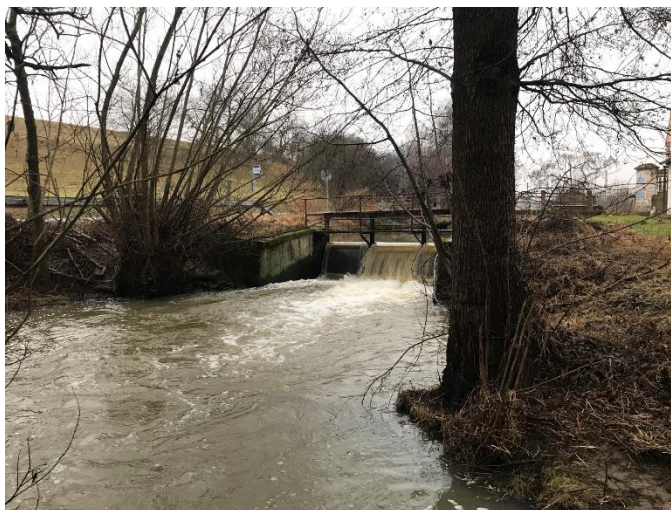
Obrázek 18: Pohled na jezové těleso
