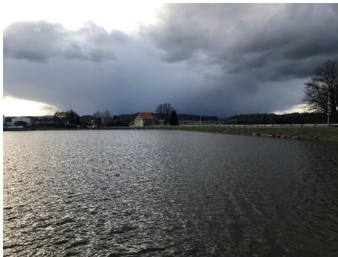
Obrázek 30: Pohled na hráz
