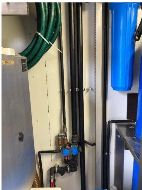
Obrázek 8: Přívod hlavního řadu
