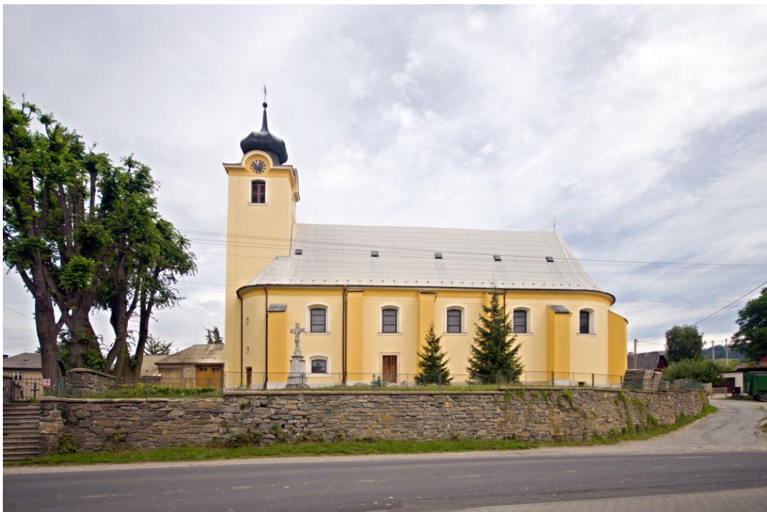
Obrázek 15: Obnova fasády a reliéfu kostela svatého Vavřince v Rudě nad Moravou 230
