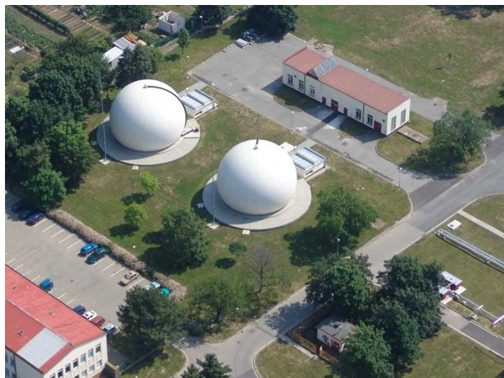
Obr. 6 Plynojemy (ČOV Modřice)
