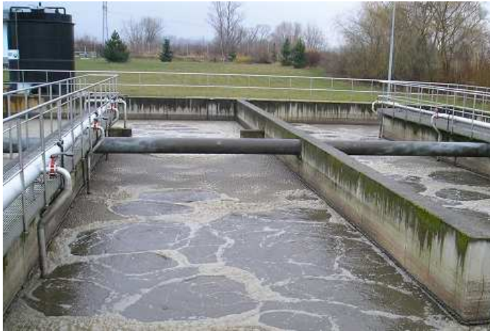
Obr. 4 Aktivační nádrž (ČOV Šumperk)
