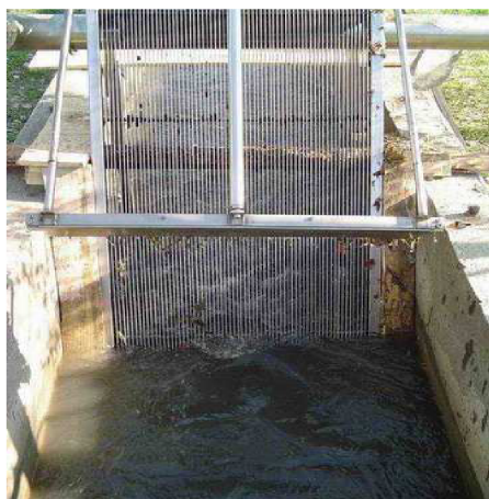
Obr. 2 Česle strojně stírané
