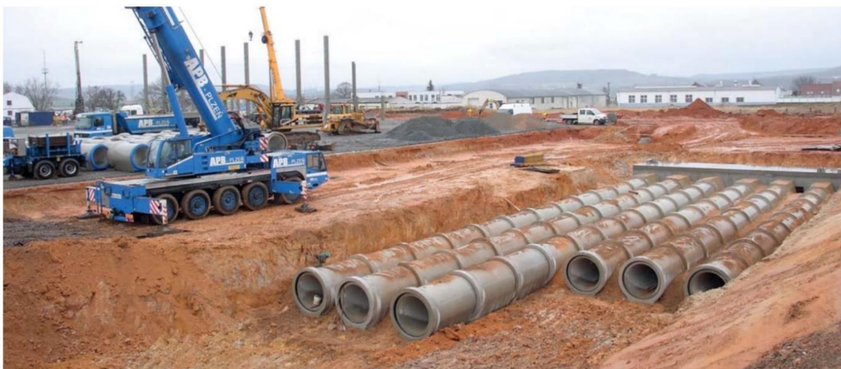
Obrázek 2.5 – Ukázka trubní retence pomocí 6 paralelně položených úseků [14]
