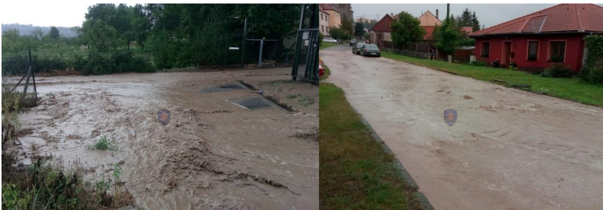
Obrázek 5.30 – Nedostačující pásová vpust u areálu Agris Jedovnice s.r.o (vlevo) a zatopená ulice Legionářská (vpravo) při přívalové srážce 27.7.2019 [45]
