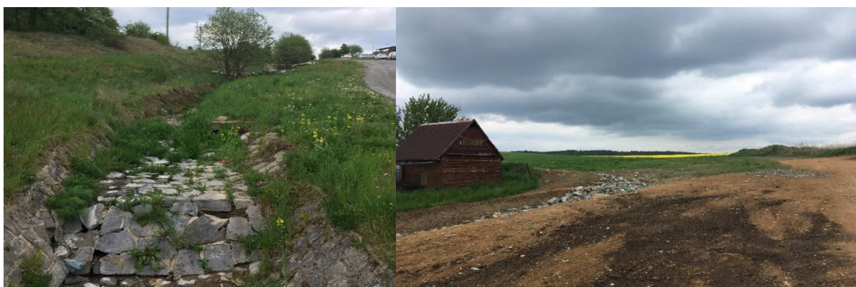
Obrázek 5.29 - Dočasná vodoteč s ochrannými hrázkami (vlevo) a nátok do vodoteče u ZP 2 (stav v květnu roku 2020) (vpravo)
