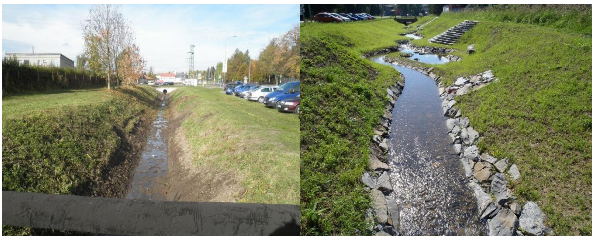
Obrázek 3.1 - Revitalizace Kobylího potoka v Bruntále v rámci programu „Vracíme vodu lesu“ – stav před (vlevo) a po (vpravo) revitalizaci [22]
