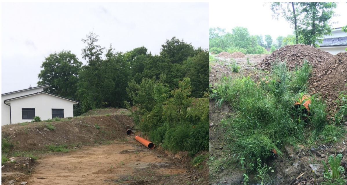
Obrázek 5.25 - Ochranná hráz (vlevo) a nátoky do odvodňovacích potrubí za propustkem (vpravo)
