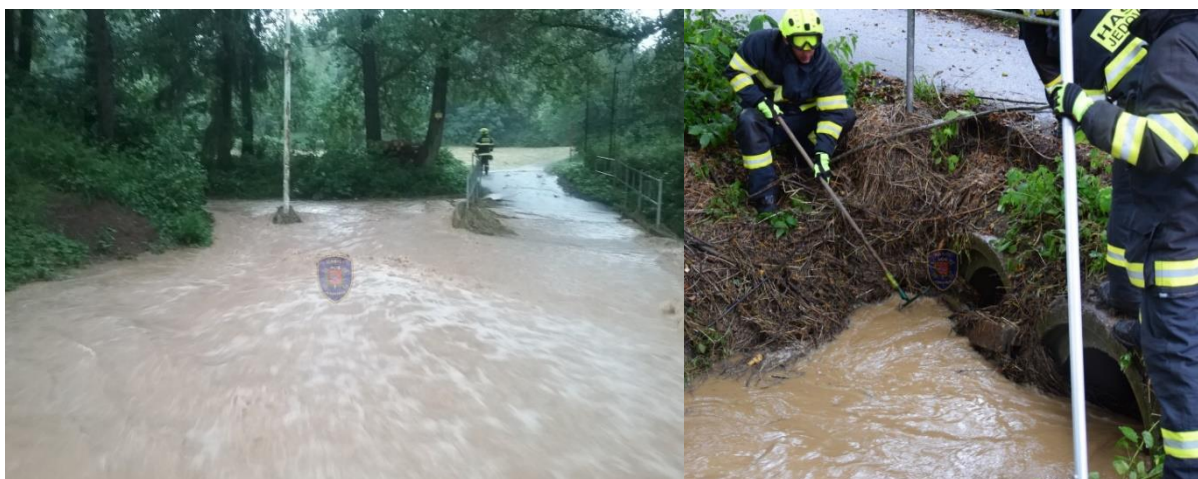
Obrázek 5.26 - Nekapacitní propustek na Kotvrdovickém potoce při bouři 20.6.2019 (vlevo) a 27.7.2019 (vpravo) [45]
