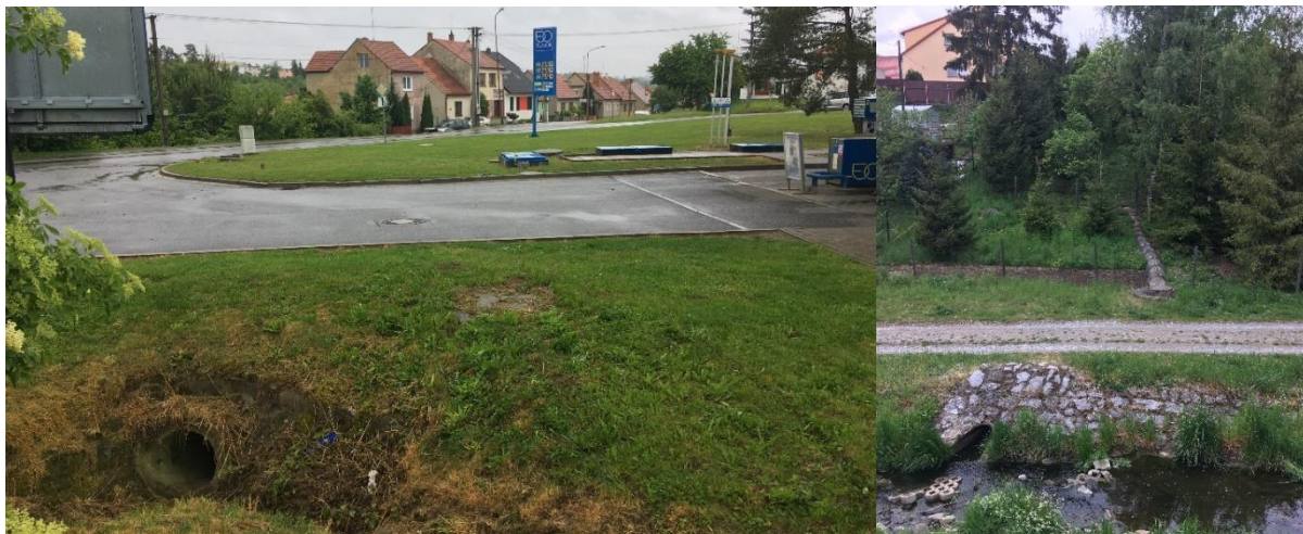
Obrázek 5.27 – Povodí 1b – jeden ze 2 nátoků do dešťové kanalizace u ČS PHM (vlevo), vyústění dešťové kanalizace od ČS PHM do Kotvrdovického potoka (vpravo)
