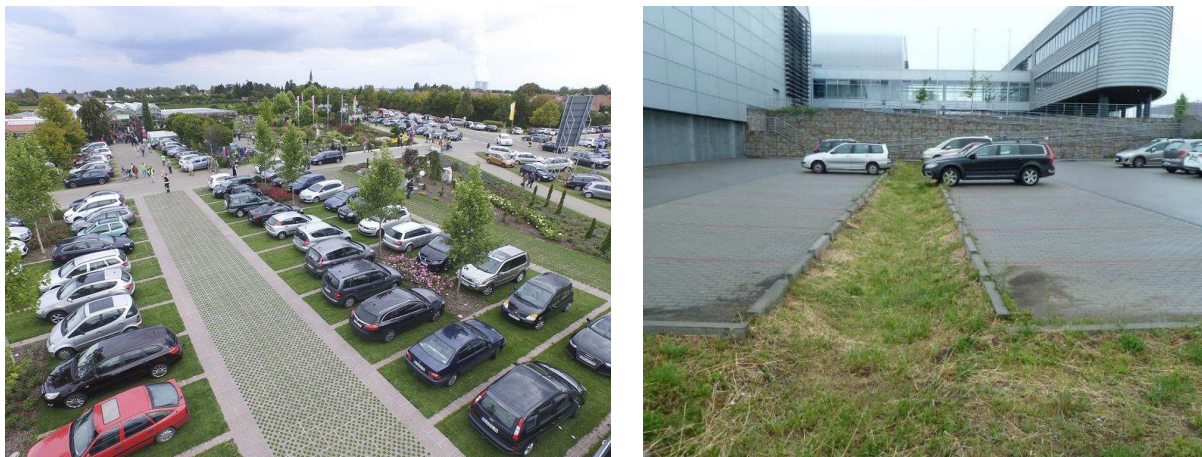
Obrázek 3.6 - Parkoviště ze zasakovacích roštů (vlevo) a vsakovací průleh u Masarykovy univerzity v Brně (vpravo) [30][27]
