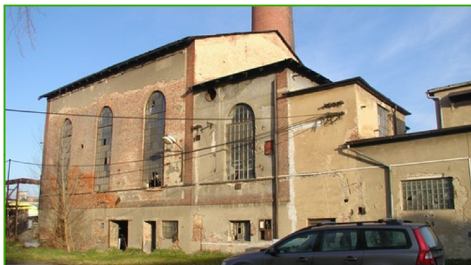
Brownfield "Kotelna" ve Valašském Meziříčí
