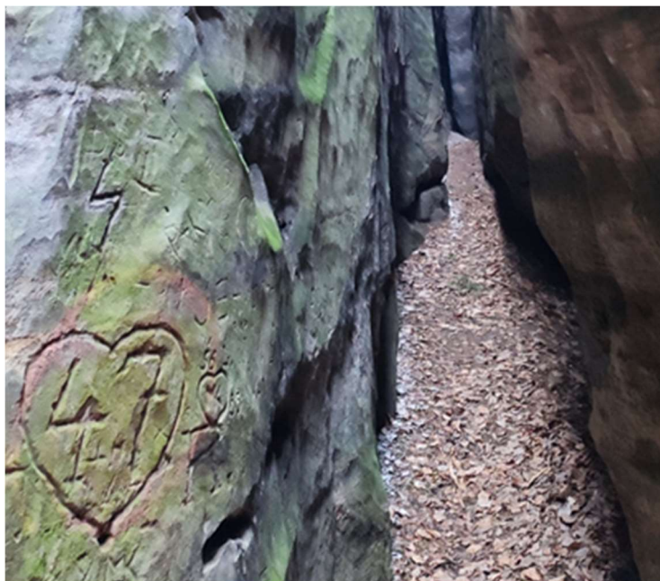
Obr. 8: Poškození skal rytím v EVL Příhrazské skály (zdroj: autor)
