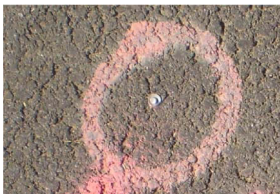
Obr. 3 – Ukázka stabilizace pomocného měřického bodu
