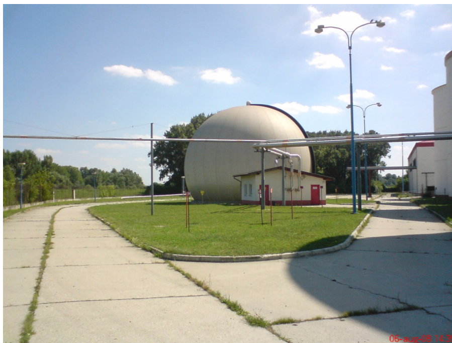
Obr. 2 Plynojem při čistírně odpadních vod [8]
