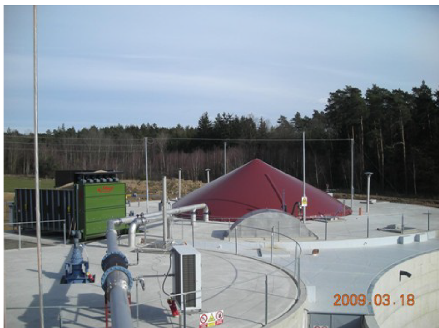
Obr. 8 Bioplynová stanice Vejprnice [25]
