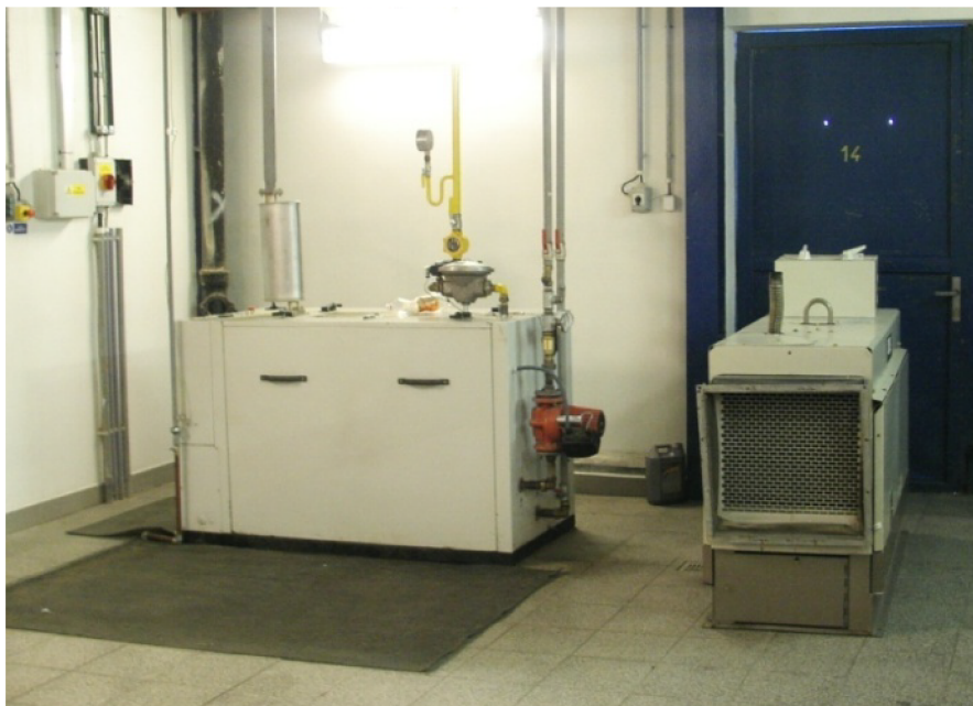
Obr. 4 Kogenerační jednotka se spalovacím motorem
