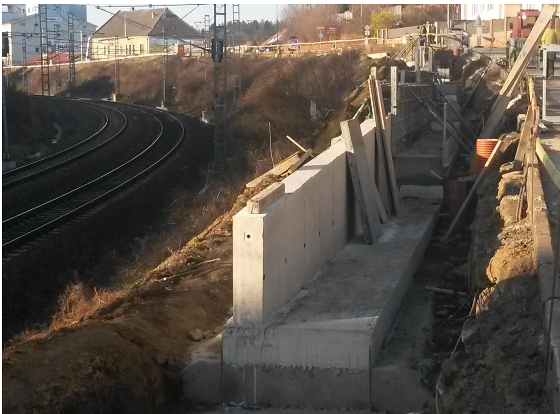
Obr. č. 32: Benešov. Nově budovaná opěrná úhlová zeď na koruně svahu (vlastní foto, březen 2014)
