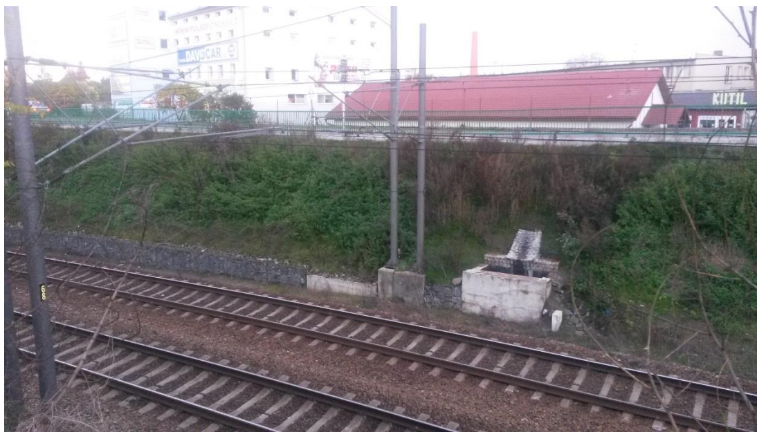
Obr. č. 34: Benešov. Sanovaný svah po šesti měsících (vlastní foto, říjen 2014)
