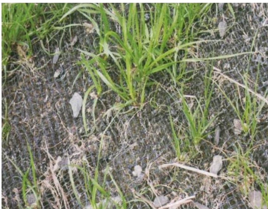
Obr. č. 24: Detail prorůstání vegetace protierozní georohoží (Hubík, 2007)
