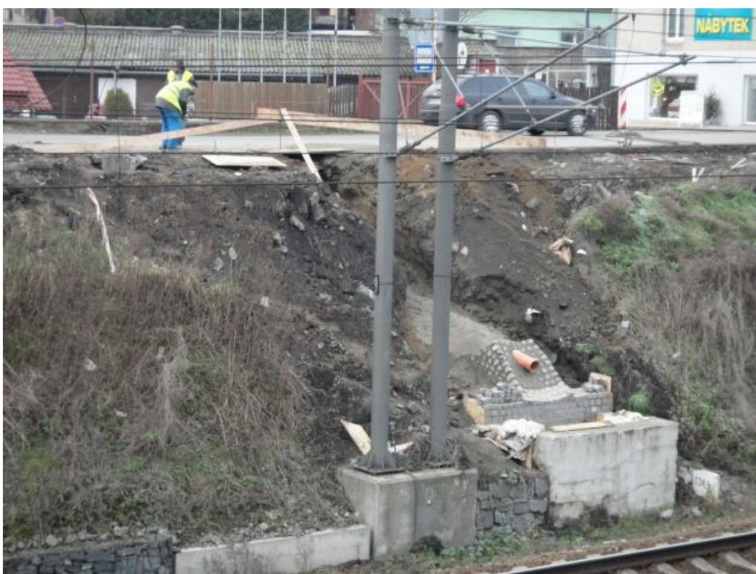
Obr. č. 33: Nově budovaná uliční vpust' (URL 10)
