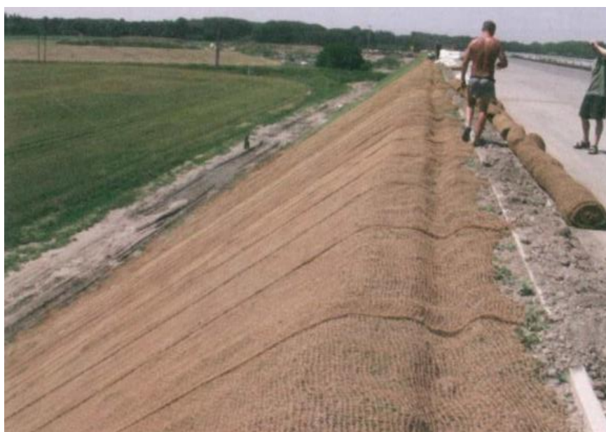
Obr. č. 25: Rohože z kokosových vláken (Řejha, 2007)
