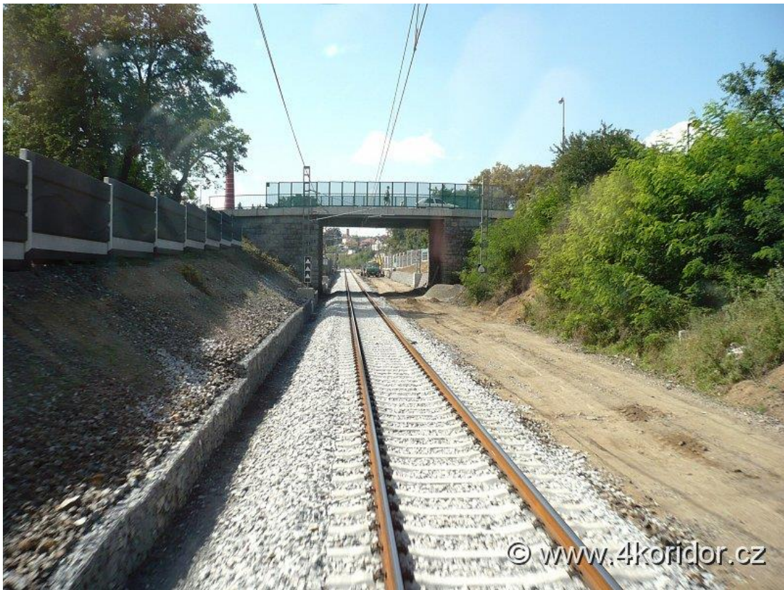
Příloha č. 3: Benešov 2007. Budované zídky z gabionů podél nového železničního koridoru (URL 3)
