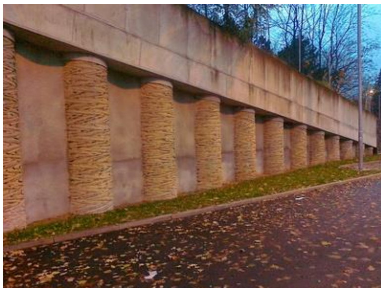
Obr. č. 14: Zárubní zeď z pilot (URL 5)
