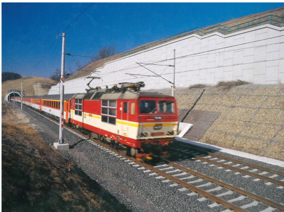
Obr. č. 18: Opěrná zeď s lícem z betonových panelů kotvená do vyztužené zeminy – zářez u Mlčechvost (Plášek a kol., 2004)
