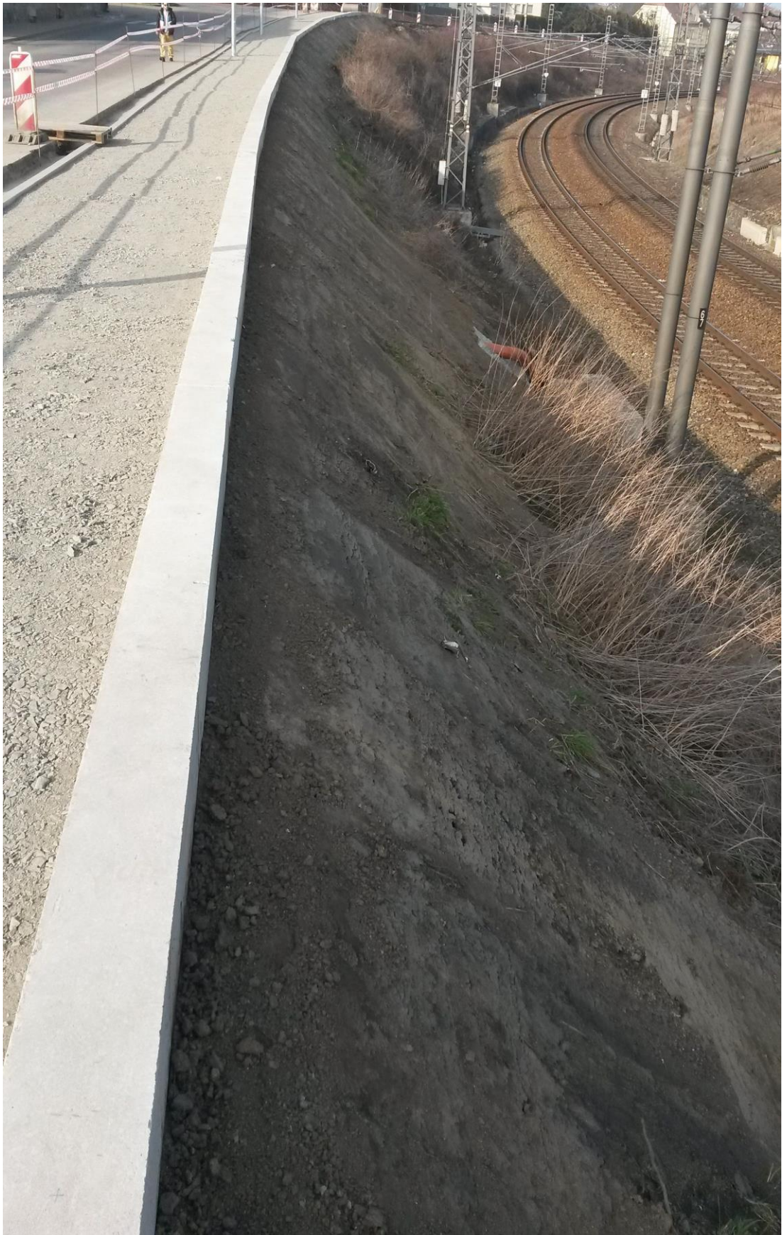
Příloha č. 5: Benešov. Zpevněný svah u opěrné zdi travními georožemi (vlastní foto, březen 2014)
