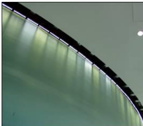
Obr. 19 Špatně vybrané LED při výrobě svítidel mohou způsobit i takovéto barevné rozdíly [15]
