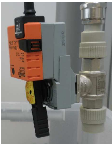
Obrázek 20: Regulační ventil R219 s pohonem LR24A-SR (Belimo)
