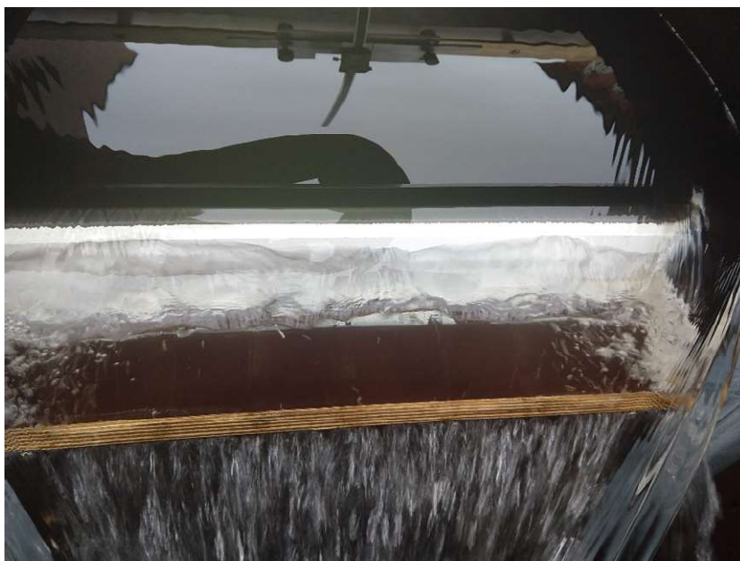
Obr. 45: Přepad ovlivněný konstrukcí přelivu
