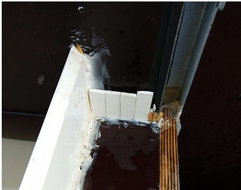
Obr. 30: Dotěsnění průsaku
