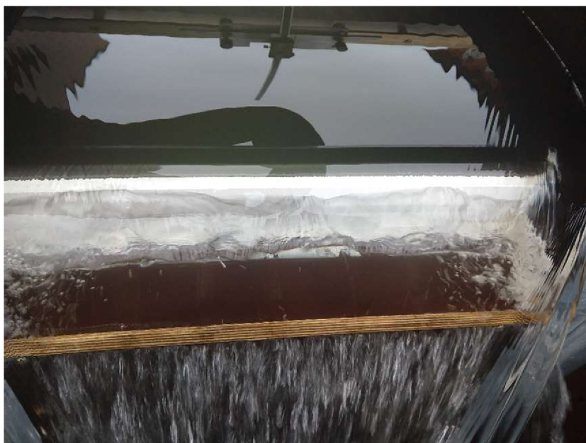
Obr. 45: Přepad ovlivněný konstrukcí přelivu
