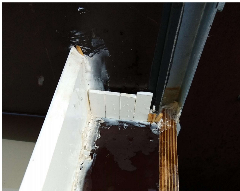
Obr. 30: Dotěsnění průsaku
