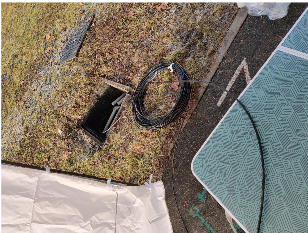
Obr. 4.6: Fotografie umístění druhé šachty u budovy T7.
