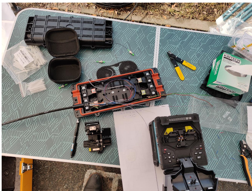
Obr. B.6: Fotografie průběhu prací ve druhé šachtě u budovy T7.
