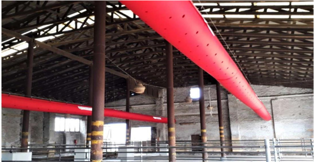
Obrázek 3.3: Tubusové větrání (Agrico.cz, 2008)
