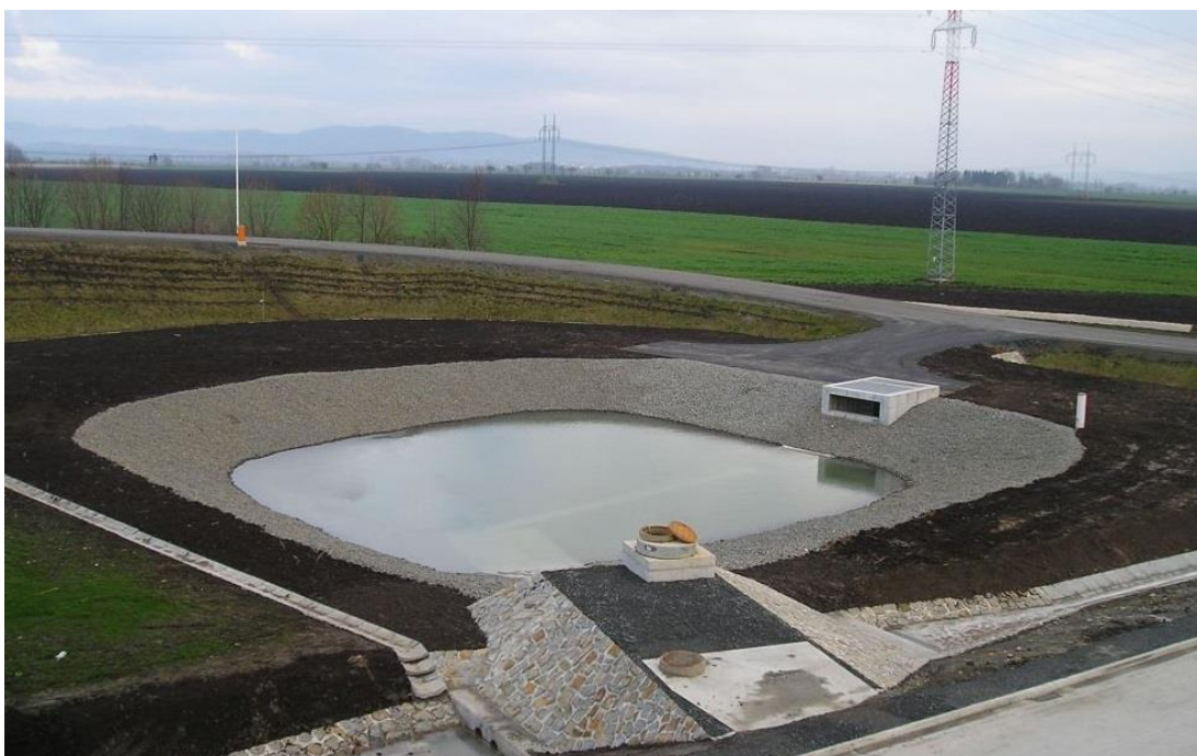
Obrázek 5: Dešťová usazovací nádrž - dálnice D1
