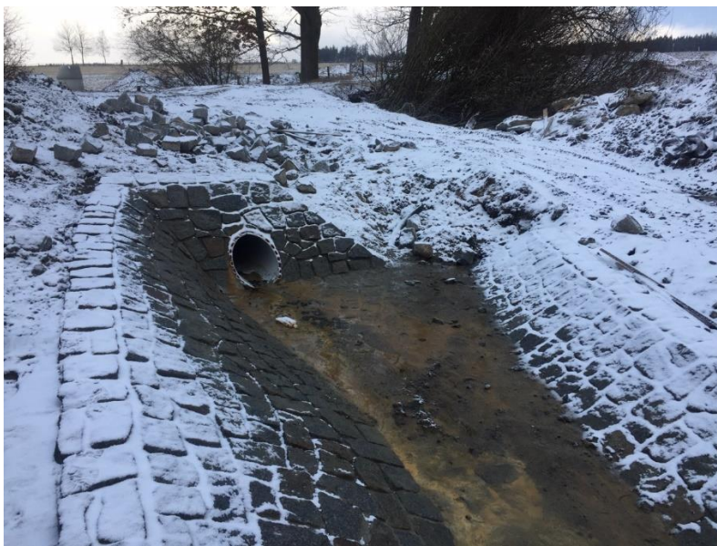
Obrázek 13: Vyústění kanalizace
