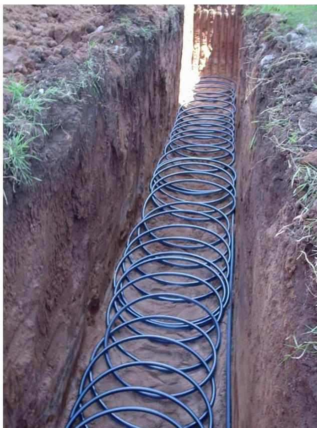
Obr. 6 Uložení výměníku typu Slink [13]
