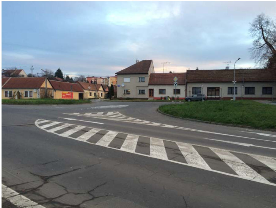
Obr. 21 Pohled na křižovatku
