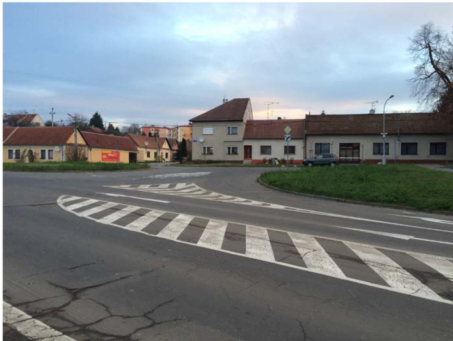
Obr. 21 Pohled na křižovatku
