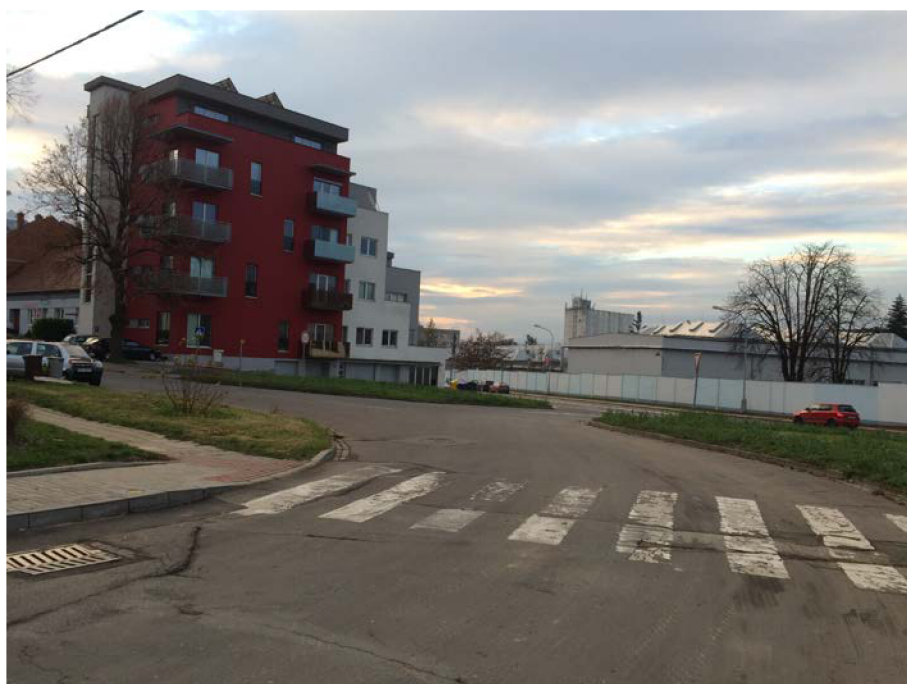
Obr. 23 Pohled z ulice Tovární
