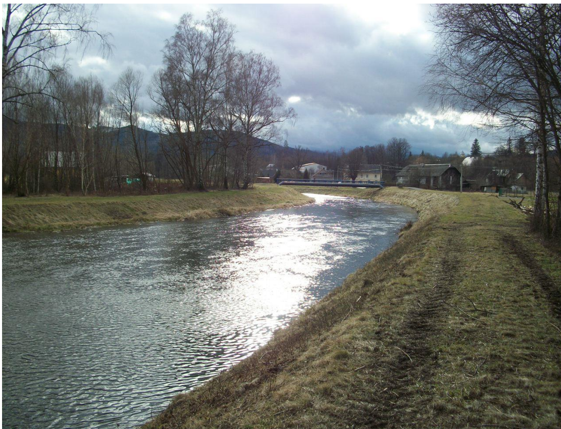
Obr. 22 – Technicky upravené koryto pravidelným lichoběžníkovým profilem v prostoru vzduť na jezu v ř.km 5,538
