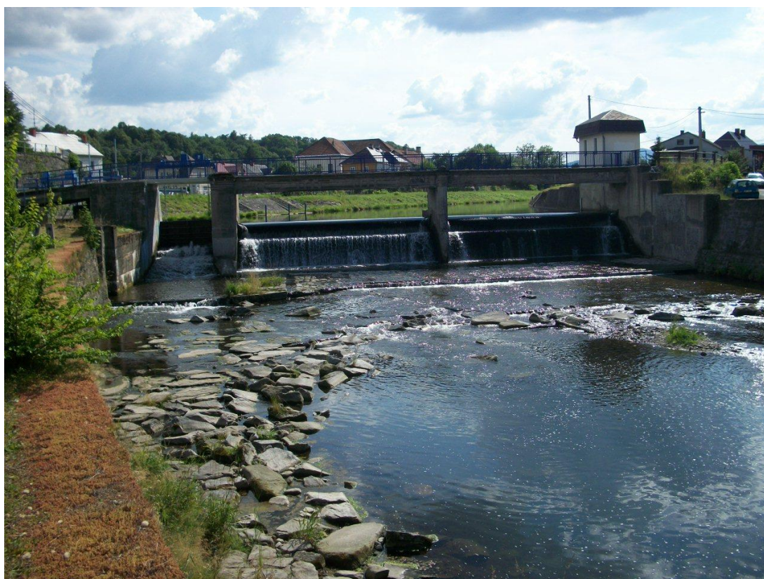
Obr. 20 – Vakový jez v obci Mikulovice v ř.km 2,850
