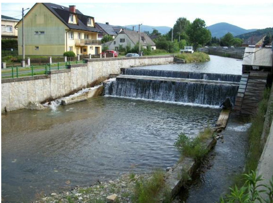
Obr. 25 – Kamenný jez, MVE a rybí přechod v obci Adolfovice v ř.km 21,649
