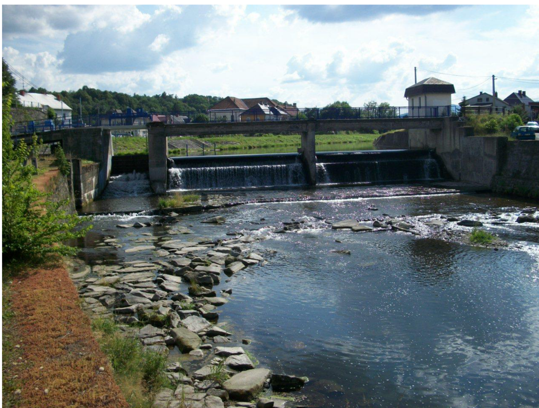
Obr. 20 – Vakový jez v obci Mikulovice v ř.km 2,850
