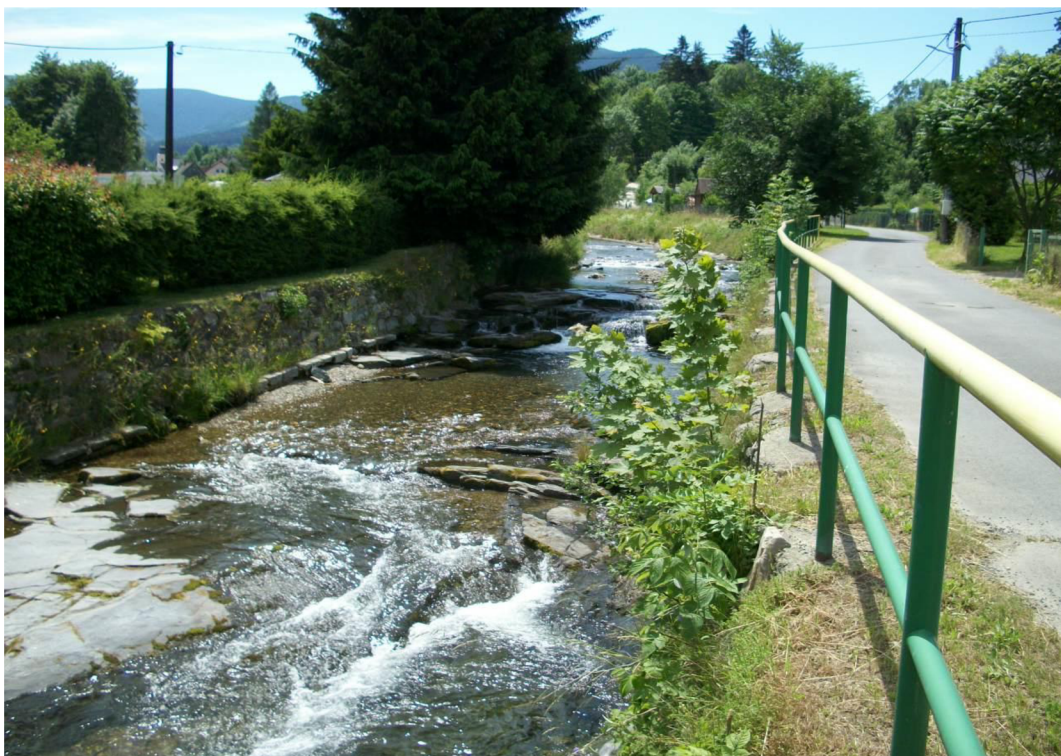
Obr. 26 – Skalní výchozy ve dně toku Bělá v ř.km 25,470
