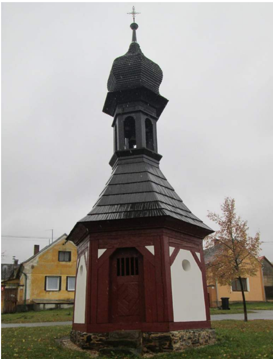
Obrázek 27 Kaple svaté Barbory v Honezovicích, zdroj: vlastní zpracování [15. 10. 2017]
