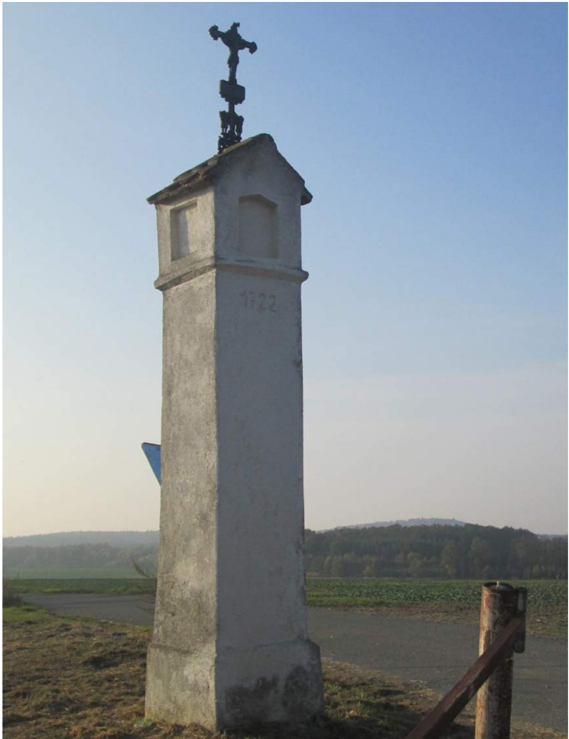
Obrázek 91 Boží muka za Přestavlky, zdroj: vlastní zpracování [28. 10. 2017]
