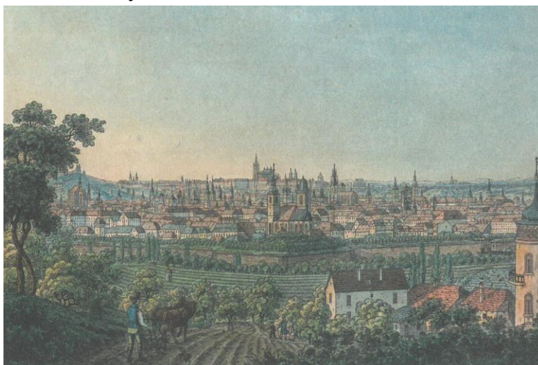
Obr. 20 Svahy nad Koňskou branou
