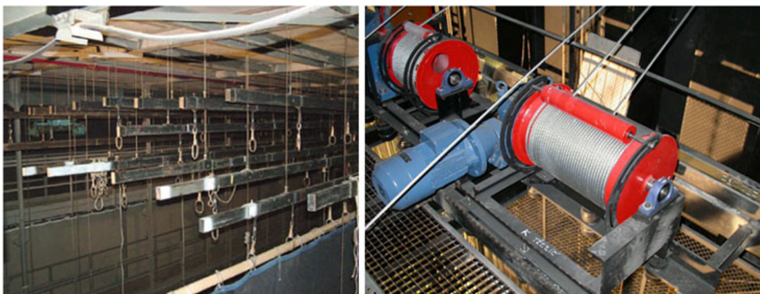
Obrázek 2.1 Horní mechanizace - vlevo perspektivní tahy nad jevištěm [1], vpravo pohony v provazišti [4]
